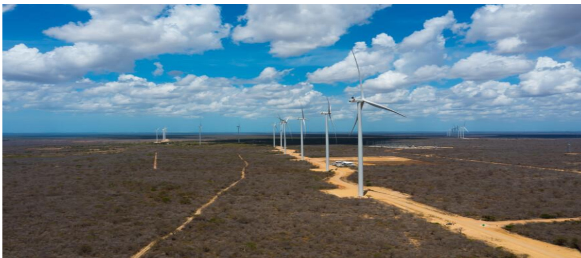
Figura1: Complexo Eólico Monte Verde I-VI
