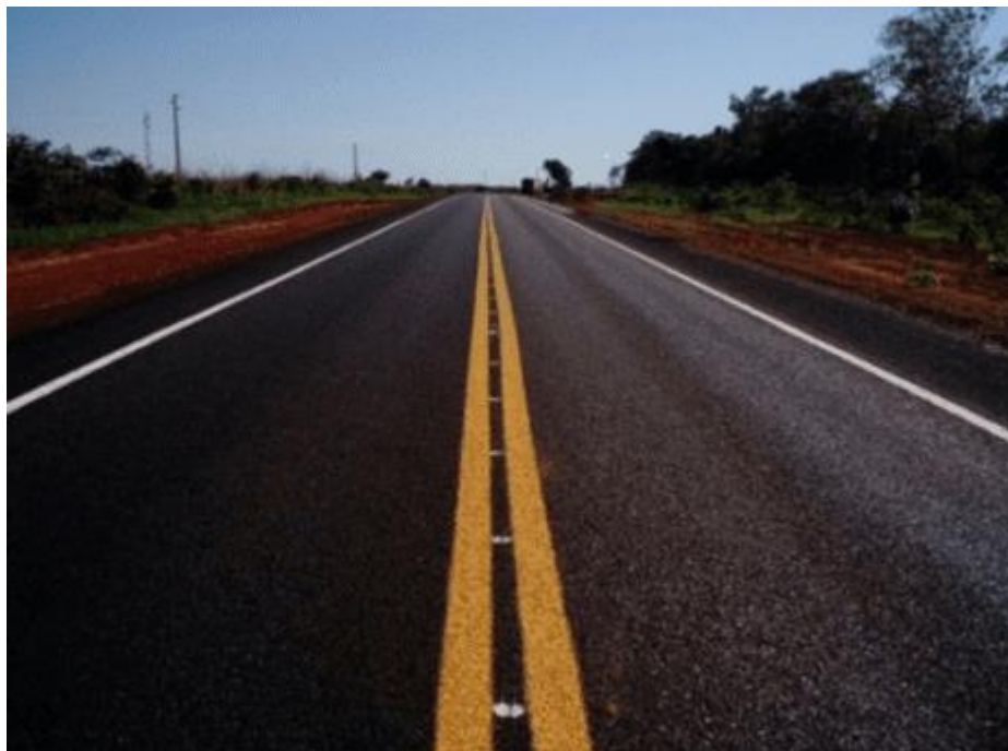
Figura 13 - Rodovia Pavimentada com CAUQ (Concreto Asfáltico Usinado a Quente)
