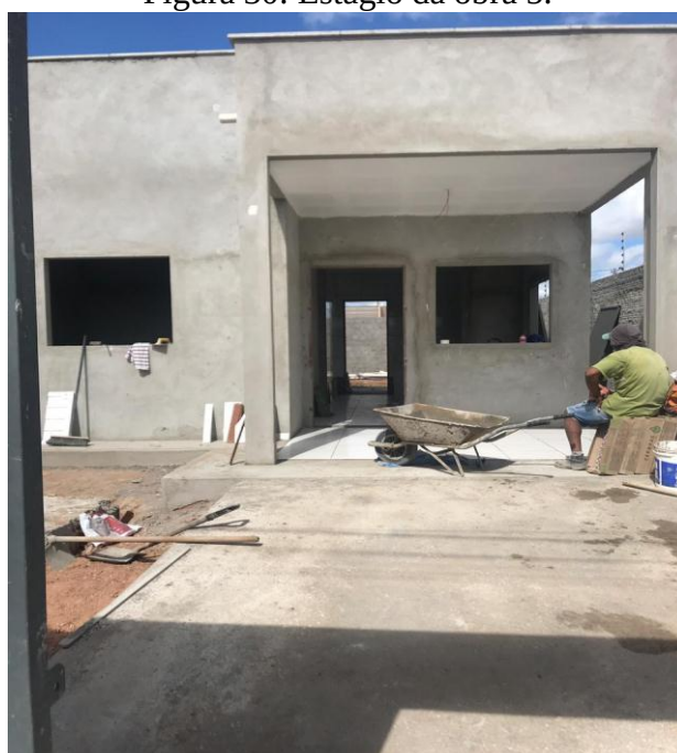
Figura 30: Estágio da obra 5.
