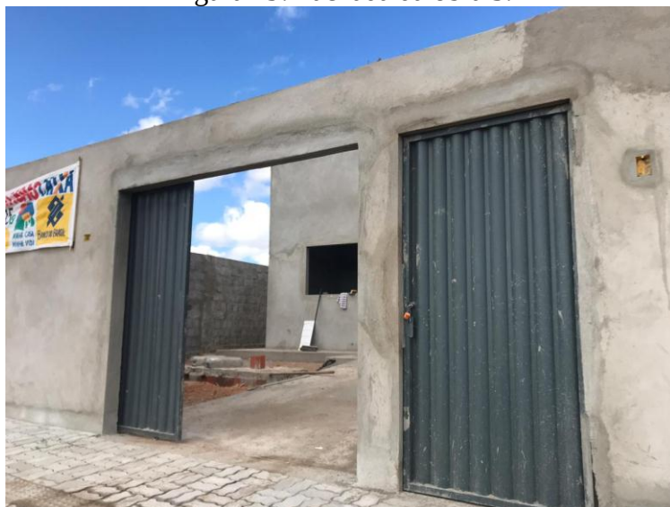
Figura 29: Fachada da obra 5.
