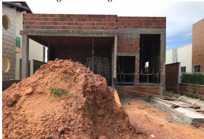
Figura 10: Estágio da obra 2.
