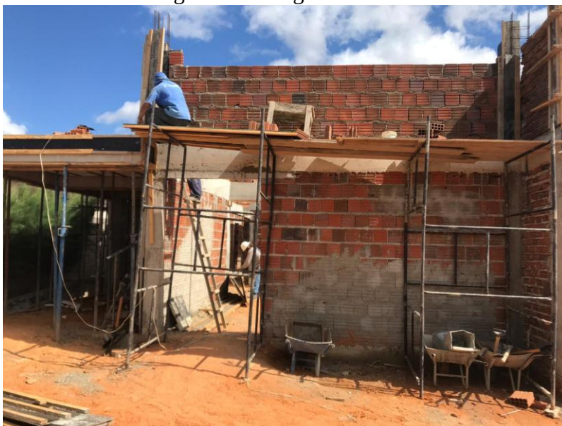
Figura 17: Estágio da obra 3.
