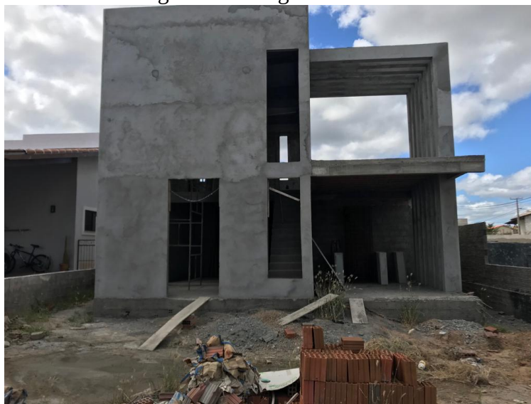
Figura 23: Estágio da obra 4.
