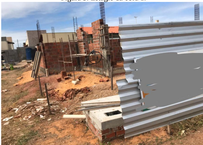
Figura 3: Estágio da obra 1.
