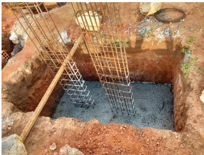
Figura 4 – CONCRETAGEM DE SAPATAS
