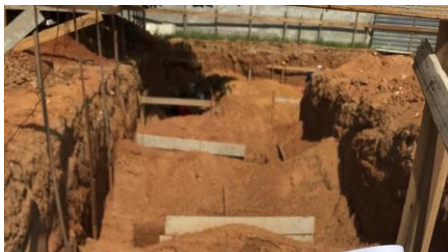
Figura 1 - ESCAVAÇÃO DE SAPATAS
