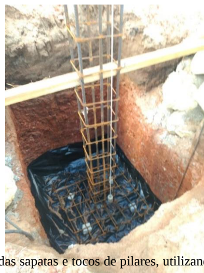
Figura 2 – LOCAÇÃO DE FERRAGEM
