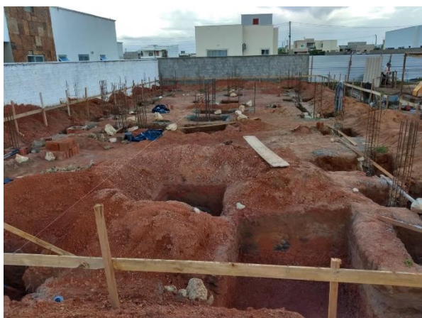
Figura 1 - ESCAVAÇÃO DE SAPATAS
