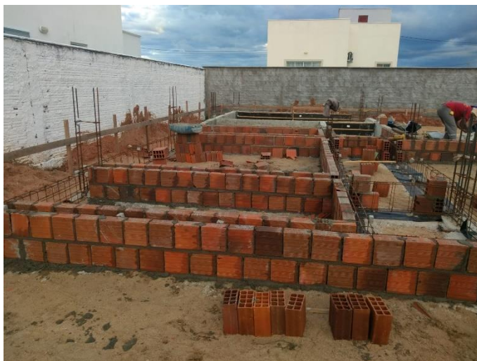
Figura 4 – ALVENARIA BALDRAME
