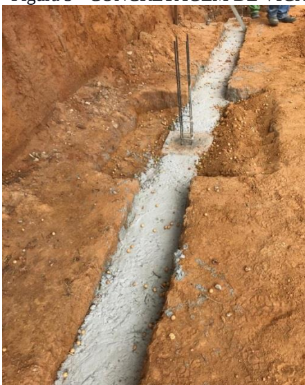
Figura 3 - CONCRETAGEM DE VIGA BALGRAME
