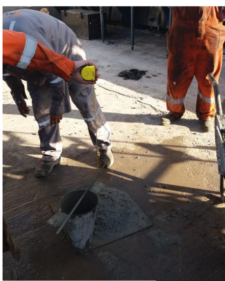
Figura 7 - ENSAIO DE PLASTICIDADE (SLUMP)
