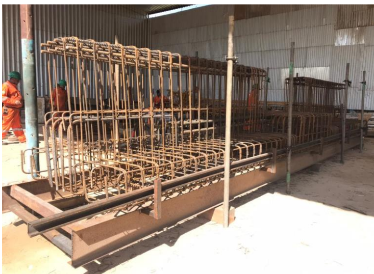
Figura 4 - ARMADURA DE VIGA EM GABARITO
