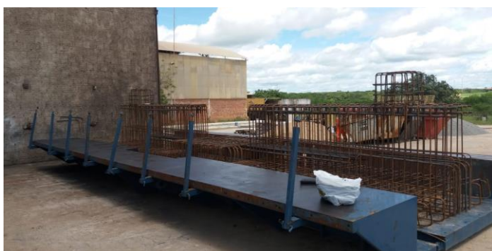
Figura 6 - LOCAÇÃO DE VIGA EM FORMA
