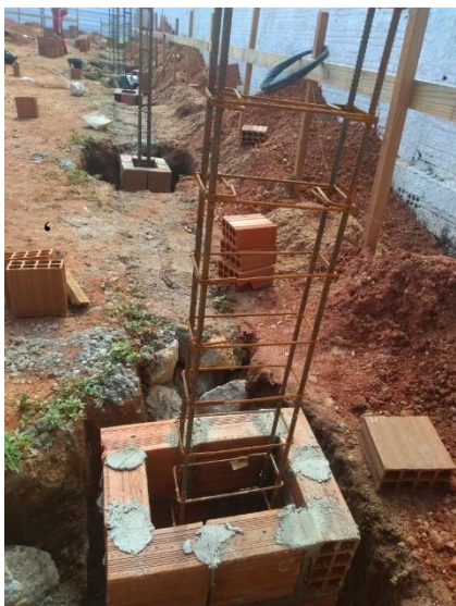
Figura 3 – FÔRMA PARA TOCOS
