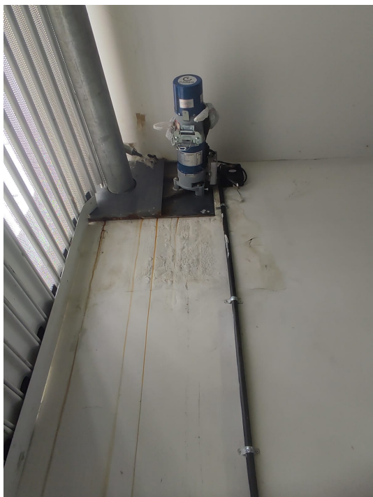
Figura 4.4 – Efflorescência, mofo e bolor da garagem da Câmara Municipal.
