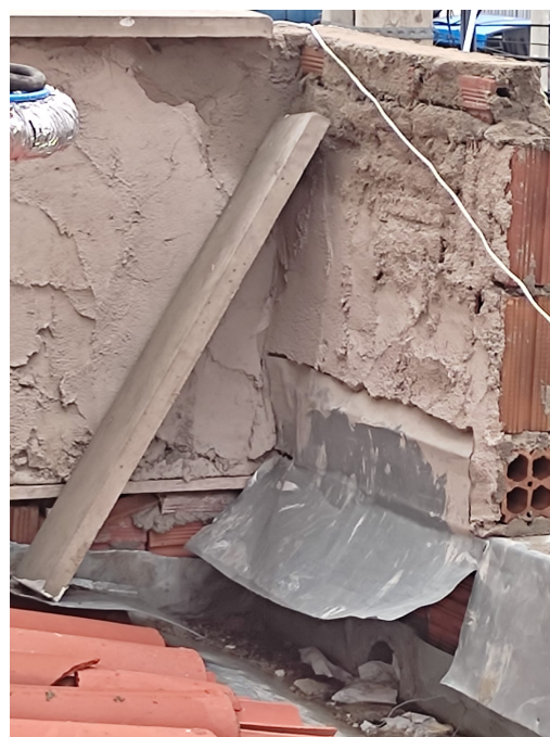
Figura 4.7 – Ilustração da calha da garagem da Câmara Municipal.
