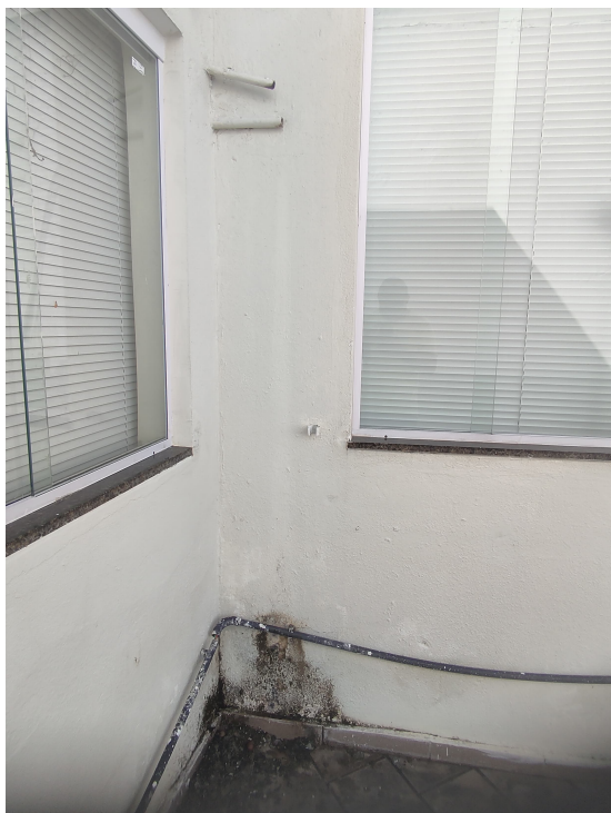
Figura 4.12 – Laje aberta acima da Sala de Arquivos.
