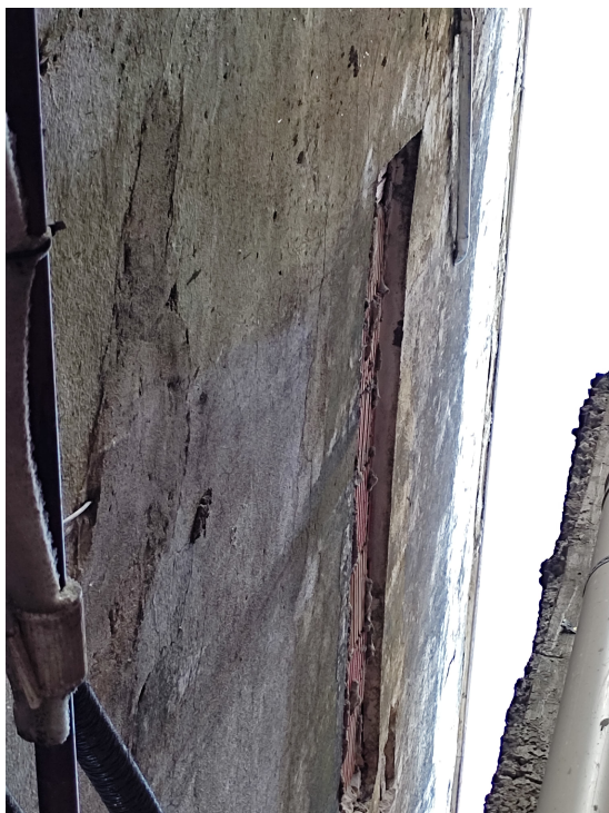
Figura 4.22 – Alvenaria exposta (fachada posterior).
