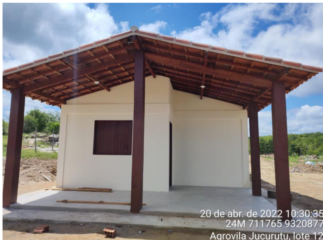
Figura 14: Fachada Frontal– Residência Unifamiliar de lote n° 12
