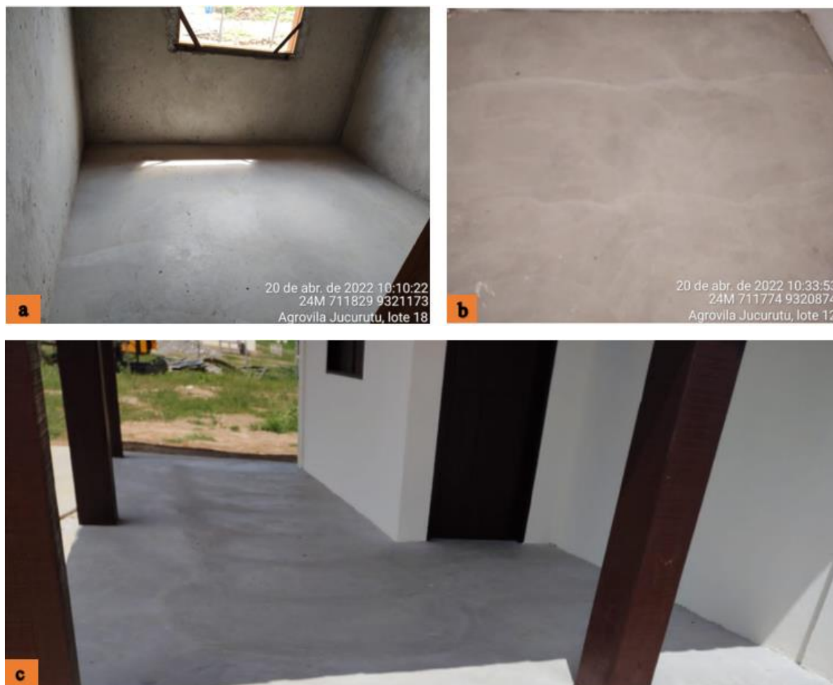
Figura 17: a) Piso Cimentado Sala, b) Piso Cimentado Quarto 01 e c) Piso Cimentado Varanda
