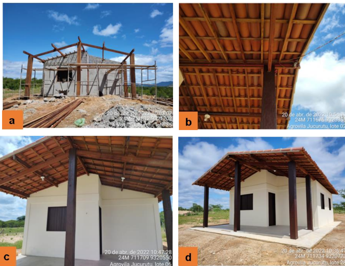
Figura 18: a) Execução da cobertura, b) Cobertura da Varanda, c) Vista da Varanda e d) Vista da Cobertura
