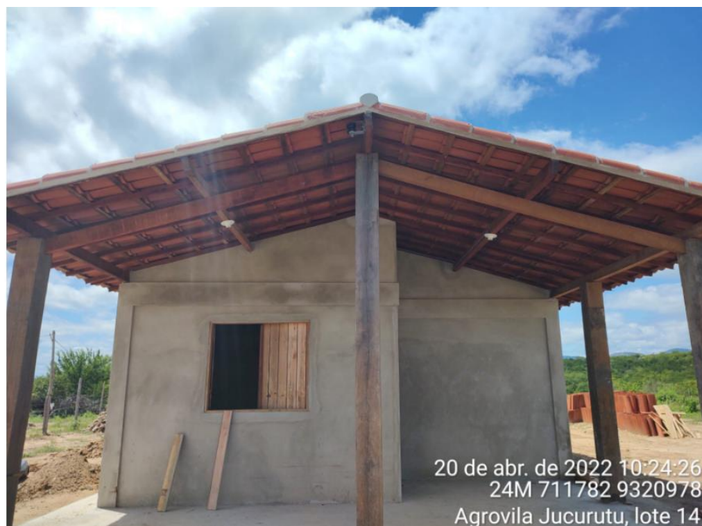
Figura 13: Fachada Frontal – Residência Unifamiliar de lote nº 14
