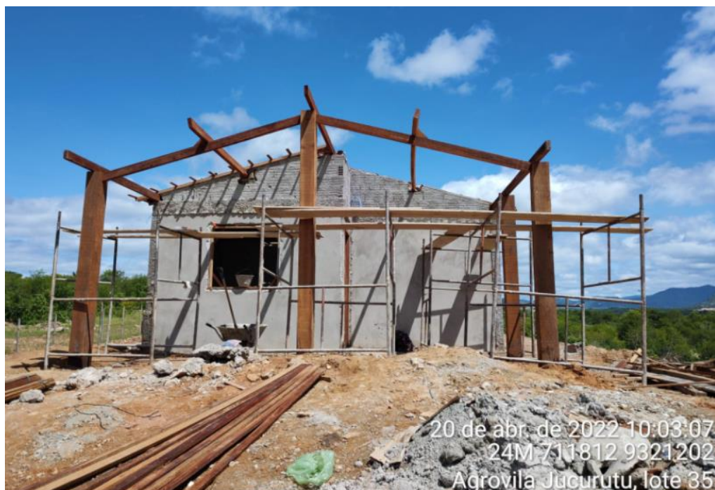
Figura 12: Fachada Frontal – Residência Unifamiliar de lote nº 35
