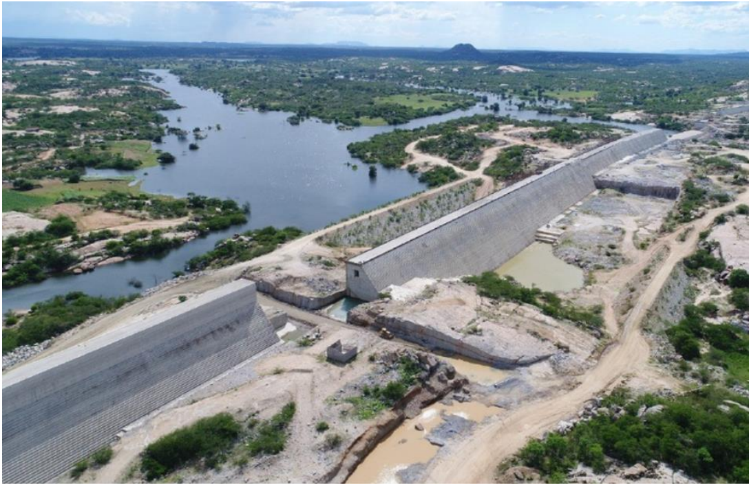
Figura 2: Vista aérea da Barragem de Oiticica
