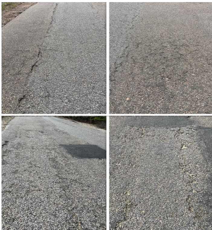
Figura 20 - Trincas
