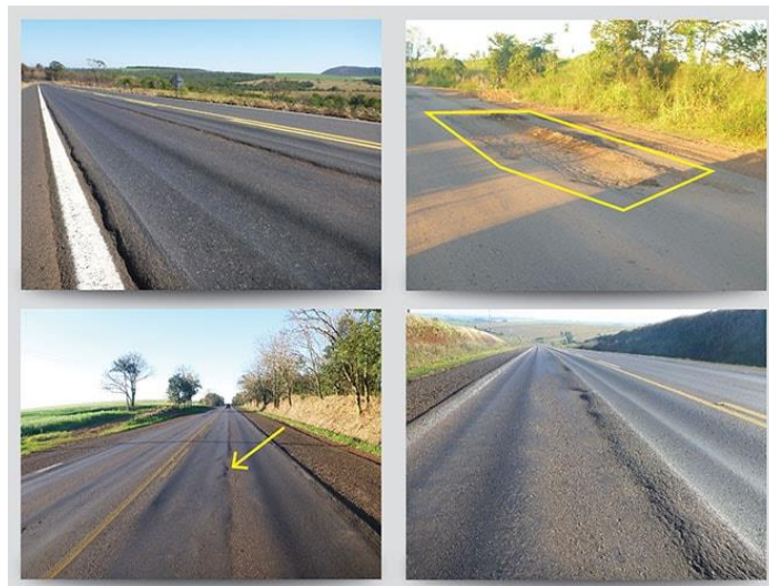
Figura 5- Afundamentos
