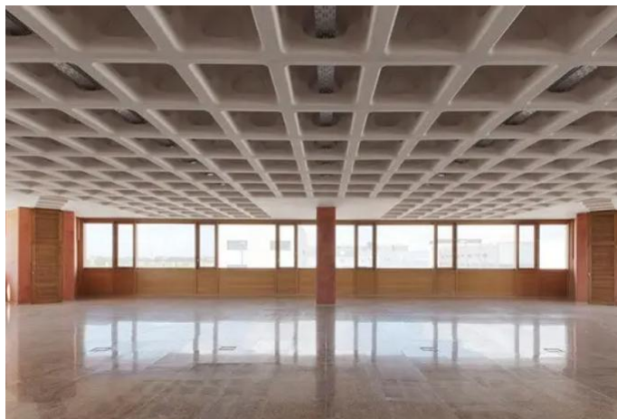
Figura 8 – Laje nervurada
