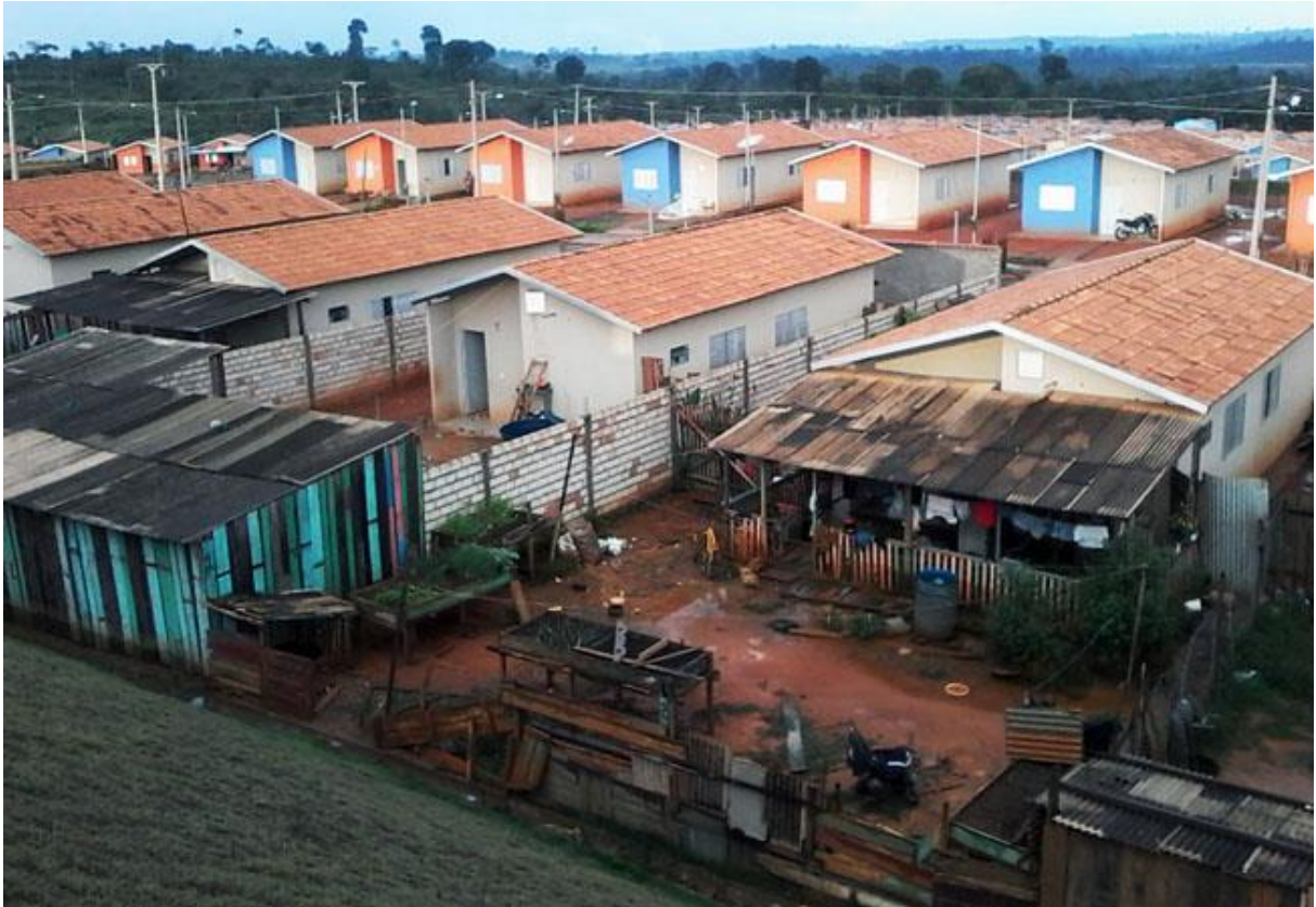
Figura 12. Reassentamento Jatobá, onde foram construídos 1.100 lotes para famílias removidas por Belo Monte.
