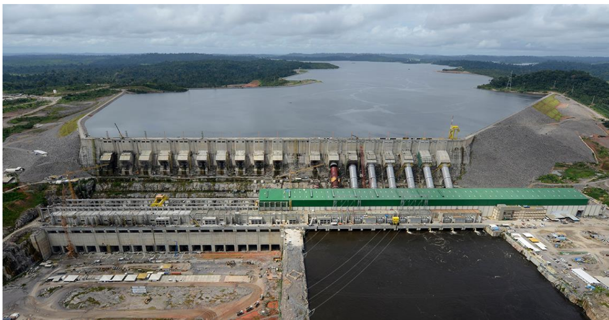
Figura 10. Usina Hidrelétrica de Belo Monte
