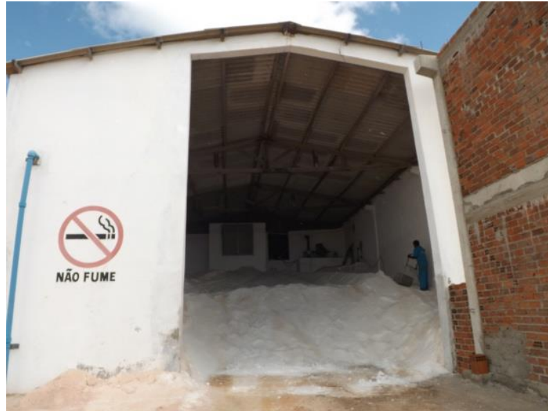
Figura 5 – Foto do Galpão de abastecimento
