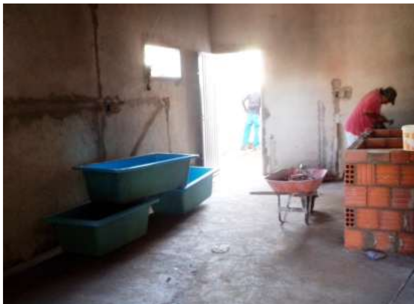
Figura 9 - Execução da obra na área que será utilizada para Banho e Tosa de animais.
