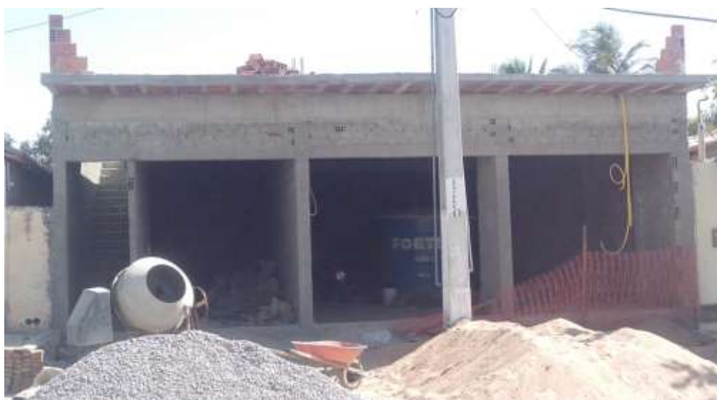
Figura 6 - Local da obra. Foto tirada pelo autor durante as visitas técnicas.
