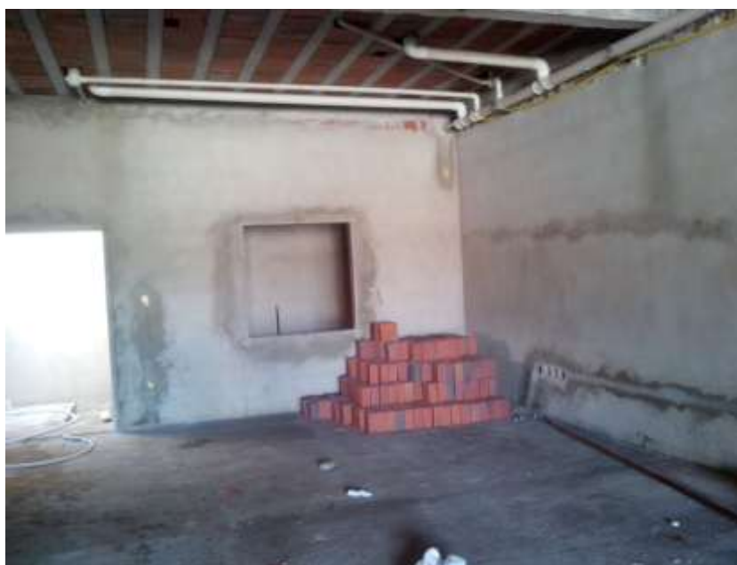
Figura 8 – Foto da obra tirada durante a sua fase de execução
