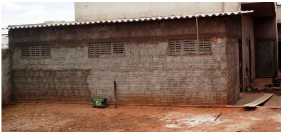
Figura 13 - Depósito construído com área de 28 m 2 .
