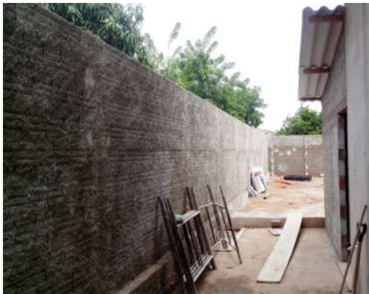
Figura 14 - Parede externa (muro) construída na área livre do terreno.
