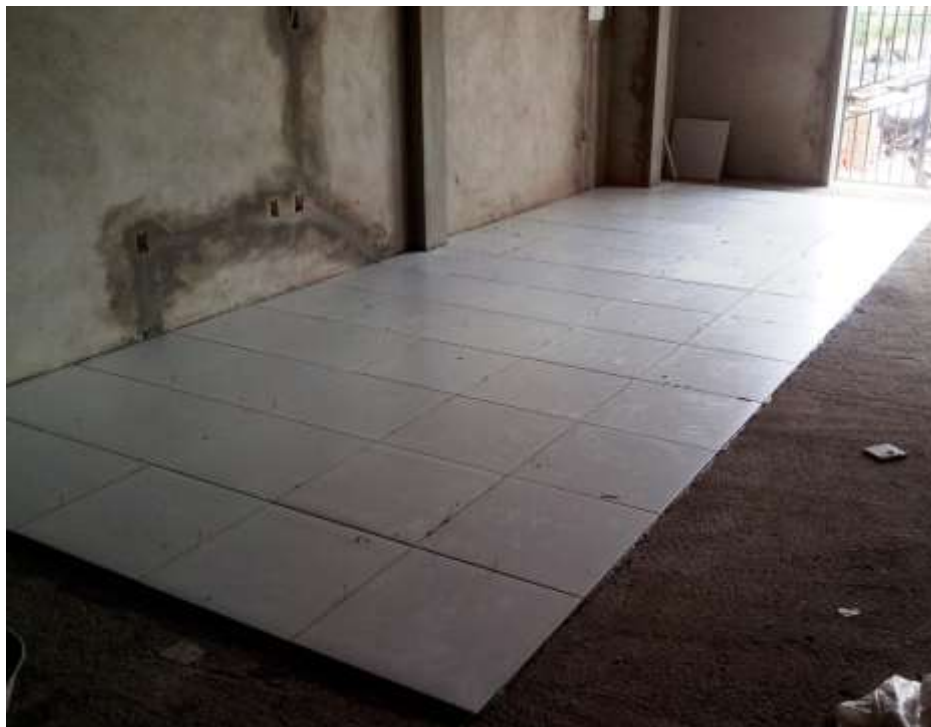
Figura 15 - Piso em porcelanato durante a sua fase de aplicação.
