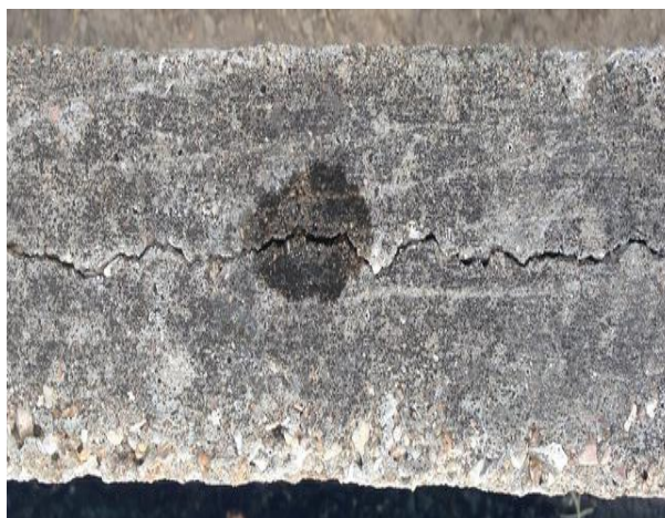
Figura 28: Fissuras paralelas 1
