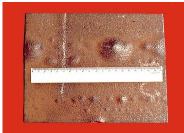
Figura 14: Corrosão por Empolamento pelo Hidrogênio
