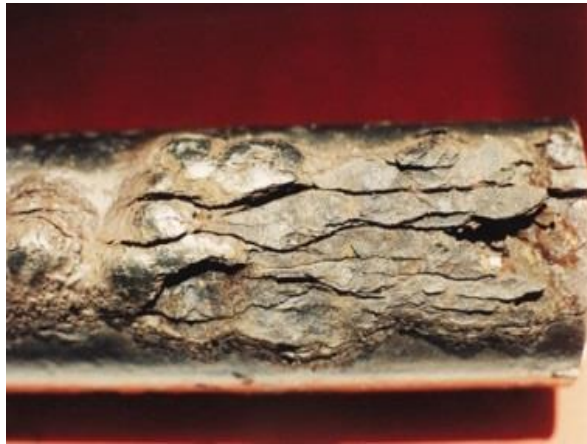
Figura 11: Corrosão por Esfoliação
