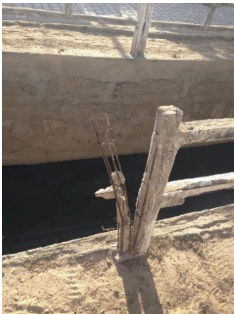
Figura 31: Estágio avançado de fragmentação
