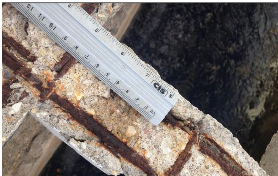
Figura 33: Armaduras expostas
