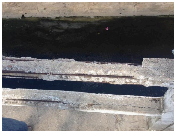
Figura 29: Fissuras paralelas 2
