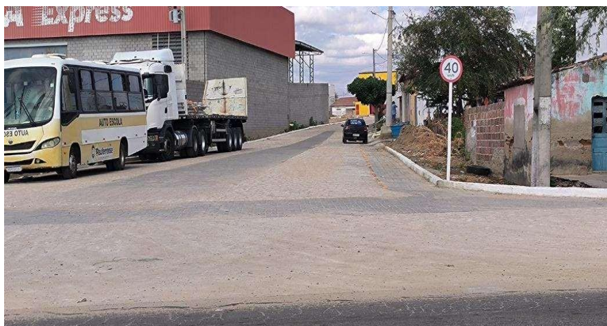
Figura 3 – Vista Frontal da Rua Palmira Chaves
