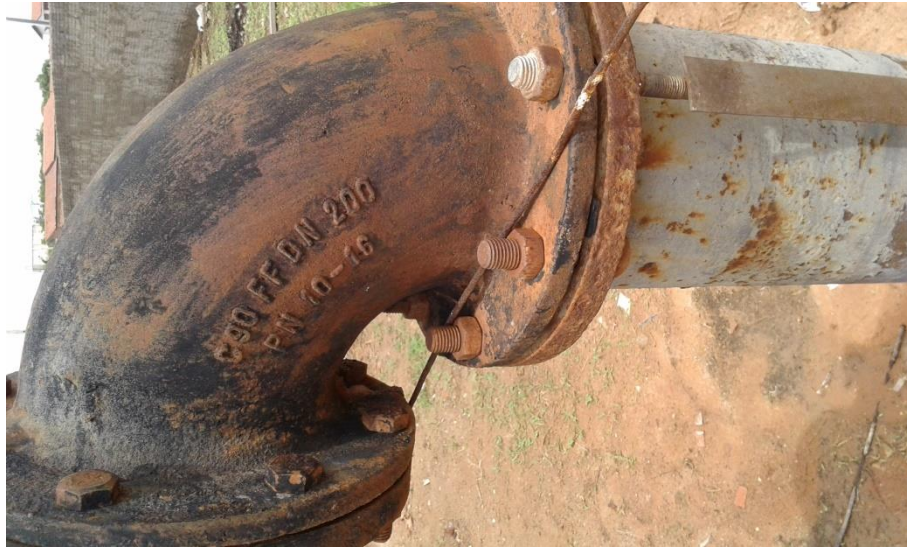
Figura 7 – Início da adutora da cidade de Tibau/RN
