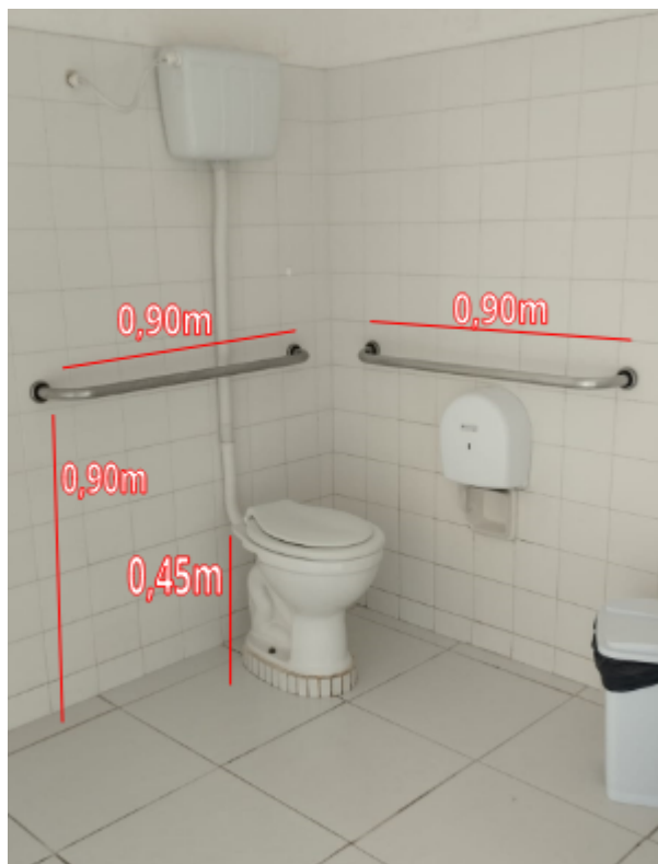
Figura 22: Interior do banheiro acessível
