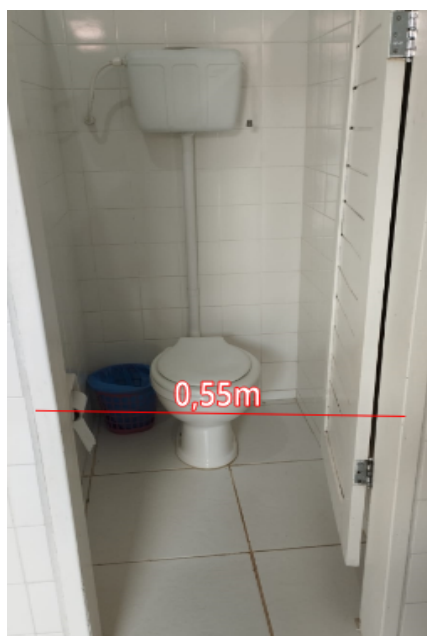
Figura 15: banheiro de uso comum
