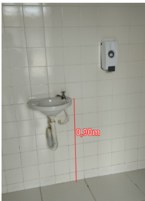
Figura 16: Lavatório banheiro acessível
