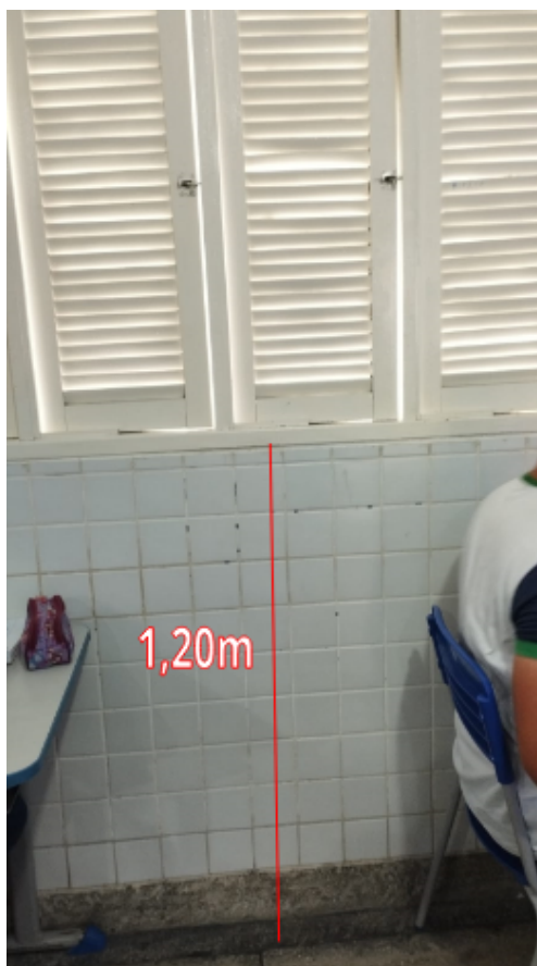
Figura 21: Comando de janelas
