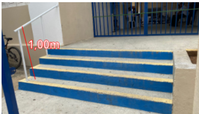
Figura 10: Escada da entrada
