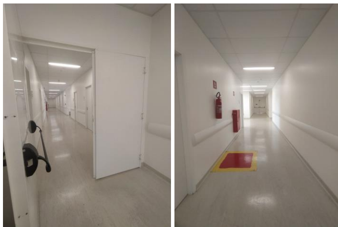
Figura 12 - Corredores de saídas de emergência do pavimento ambulatorial
