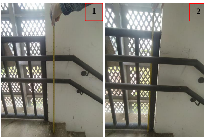
Figura 14 - Corrimão e guarda-corpo da escada do pavimento ambulatorial
