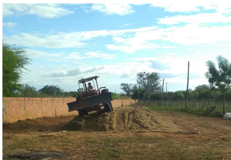
Figura 13: Processo de compactação.
