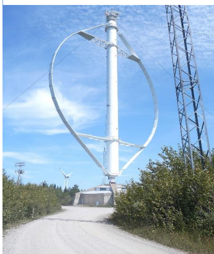
Figura 3-Turbina eólica Darrieus
