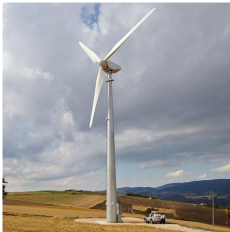
Figura 1-Turbina eólica de eixo
