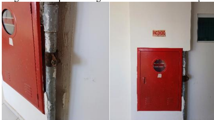
Figura 28- Reparo emergencial realizado na tubulação.
