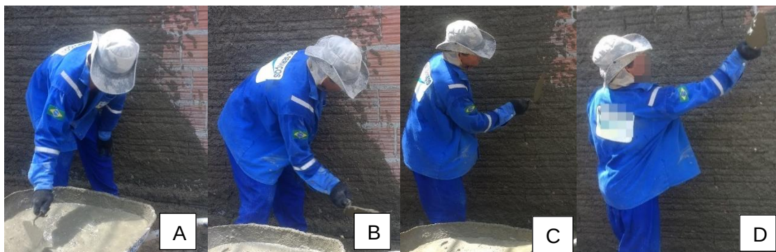
Figura 9. Aplicação do método RULA na etapa de chapiscar parede de alvenaria. (Dados da pesquisa, 2018)
