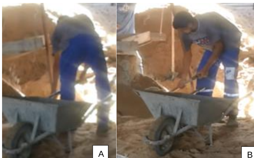
Figura 4. Aplicação do método RULA na etapa de manusear areia peneirada para levar para betoneira. (Dados da pesquisa, 2018)
