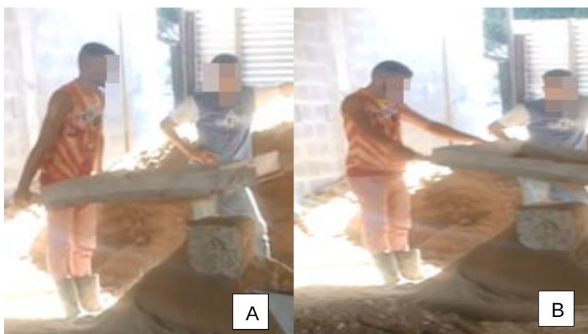
Figura 3. Aplicação do método RULA na etapa de peneirar areia. (Dados da pesquisa, 2018)
