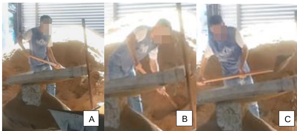
Figura 2. Aplicação do método RULA na etapa de manusear areia para peneirar. (Dados da pesquisa, 2018)
