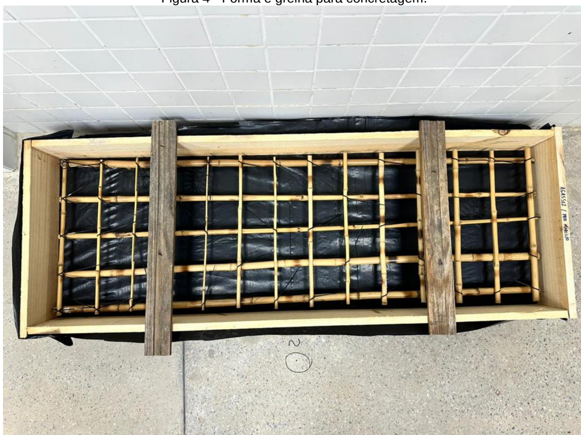
Figura 4 - Forma e grelha para concretagem.
