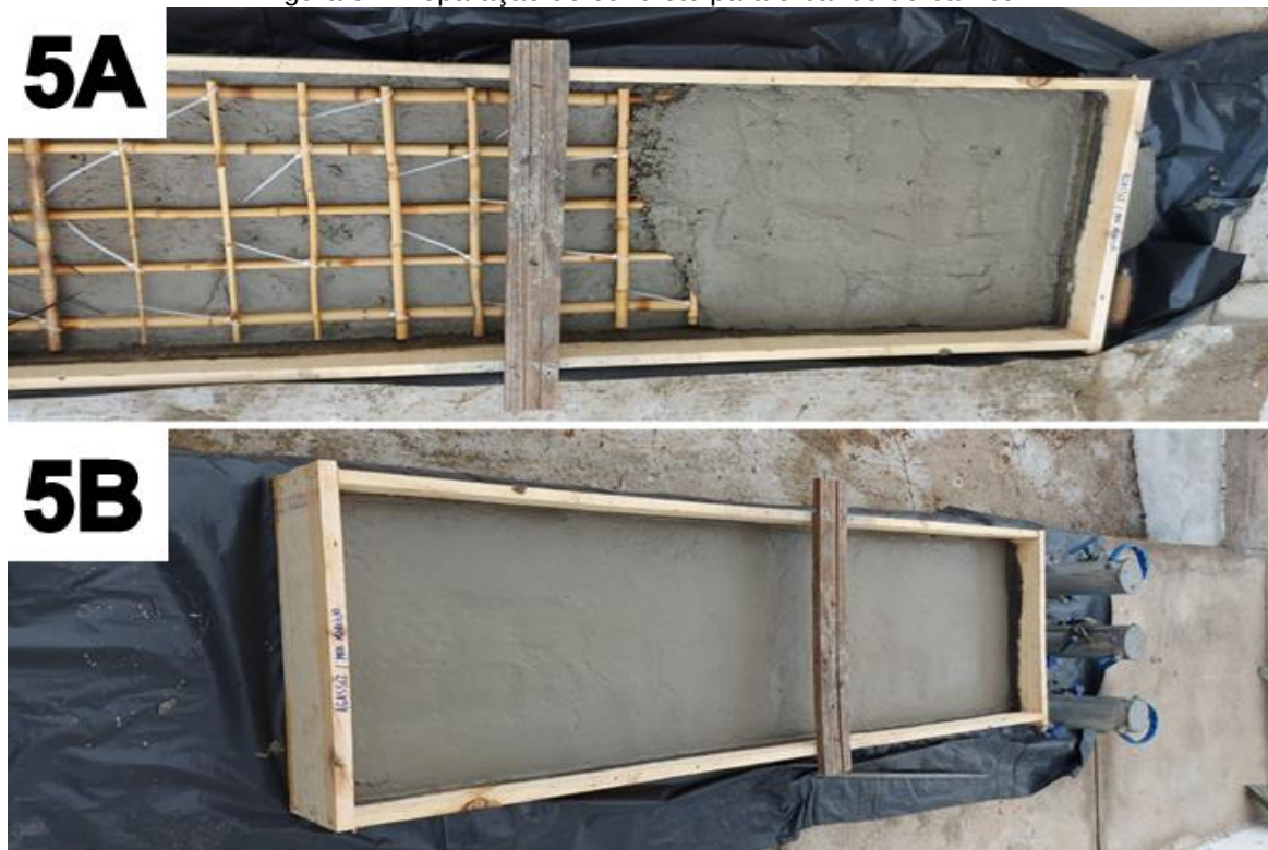
Figura 5 - Preparação do concreto para o banco de bambu.
