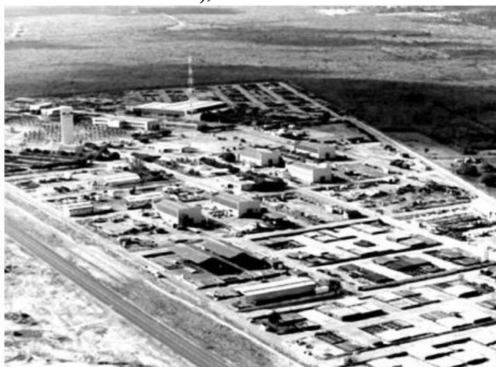
Figura 12 - Sede da Petrobras em Mossoró às margens da Avenida Wilson Rosado (Avenida do Contorno), bairro Alto do Sumaré.
