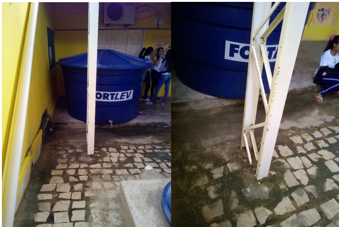
PILAR 02 Z2 = 1 CM (Pouca intensidade que não compromete o desempenho estrutural)
