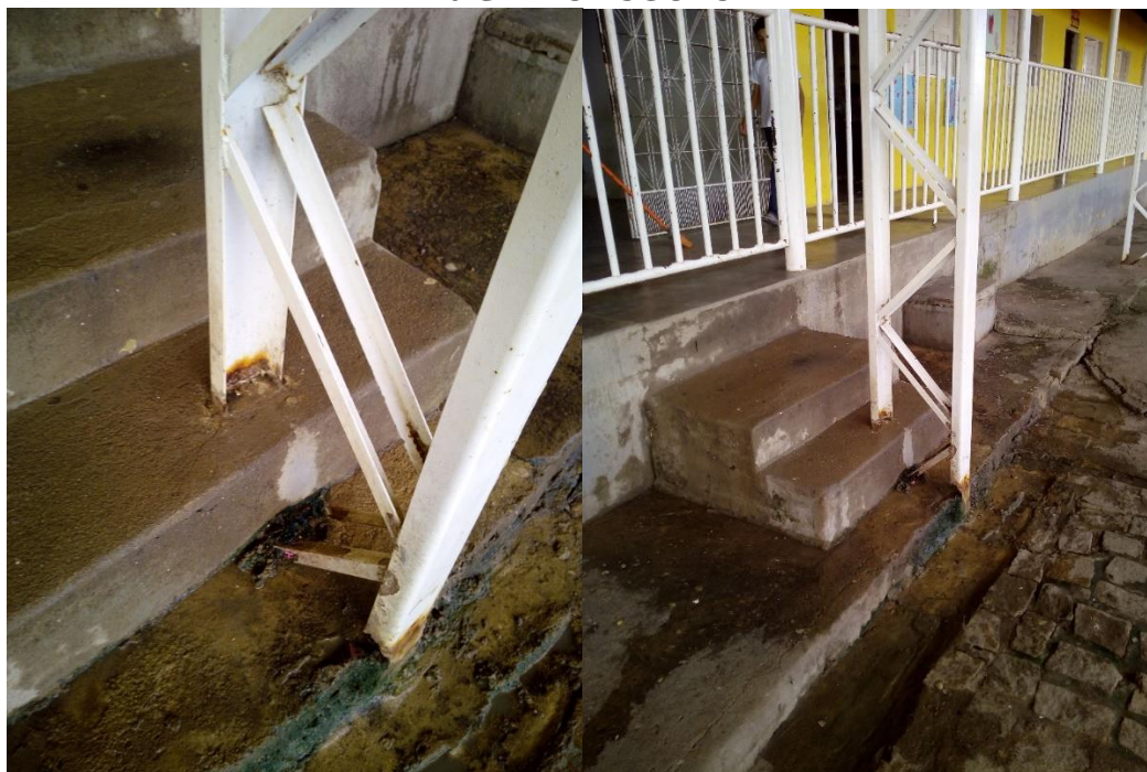
PILAR 18 Z18 = 6 CM DO DEGRAU 30 CM DA CALÇADA 40 CM DO ESGOTO
