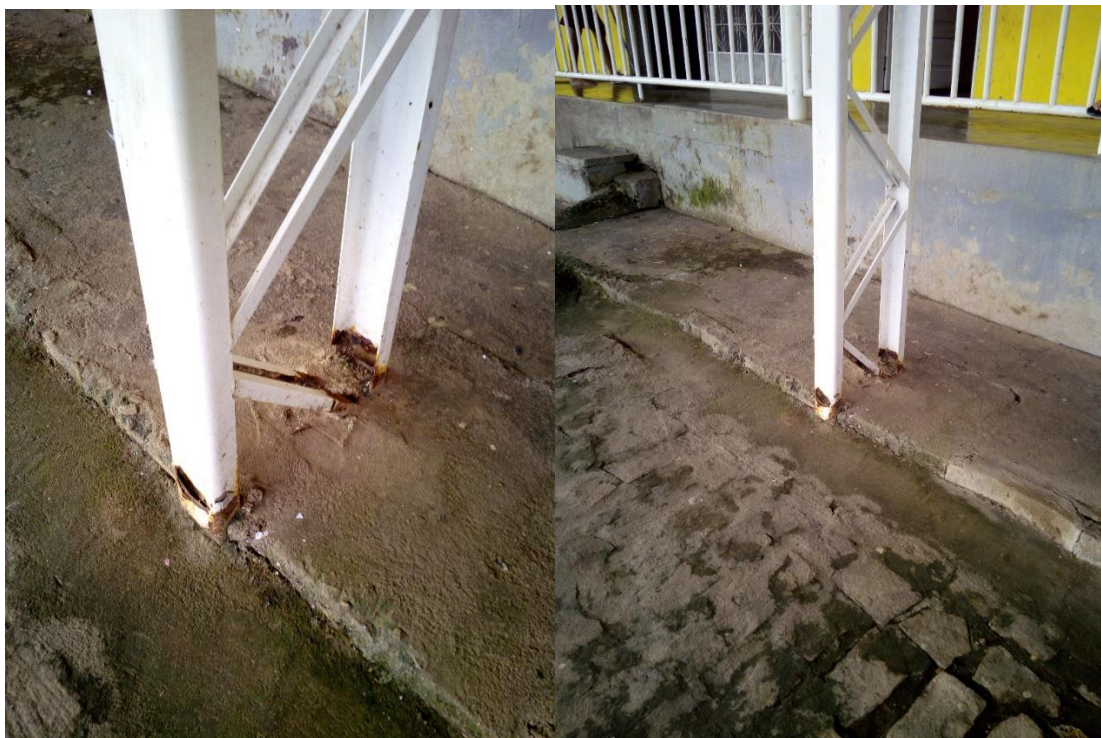
PILAR 19 Z19 = 18 CM DA CALÇADA 22 CM DO ESGOTO
