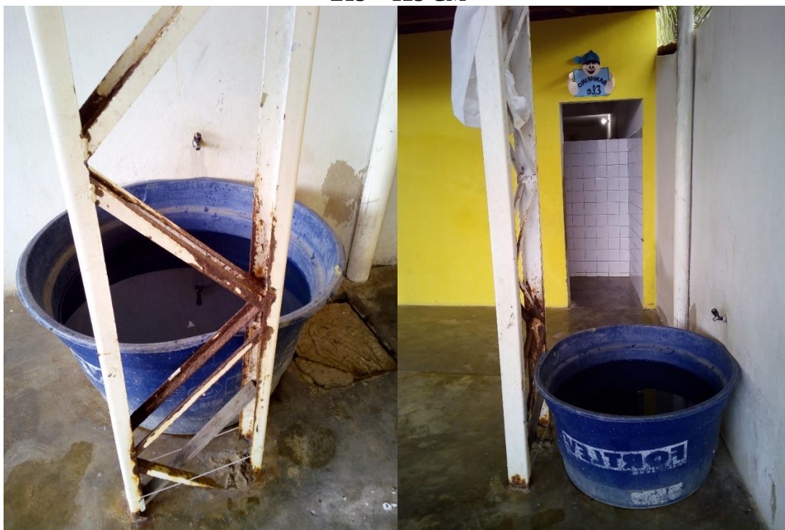
PILAR 14 Z14 = 10 CM NO BANZO 28 CM NA DIAGONAL
