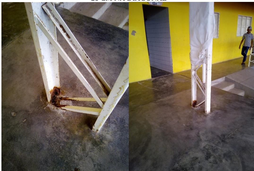
PILAR 14 Z14 = 10 CM NO BANZO 28 CM NA DIAGONAL
