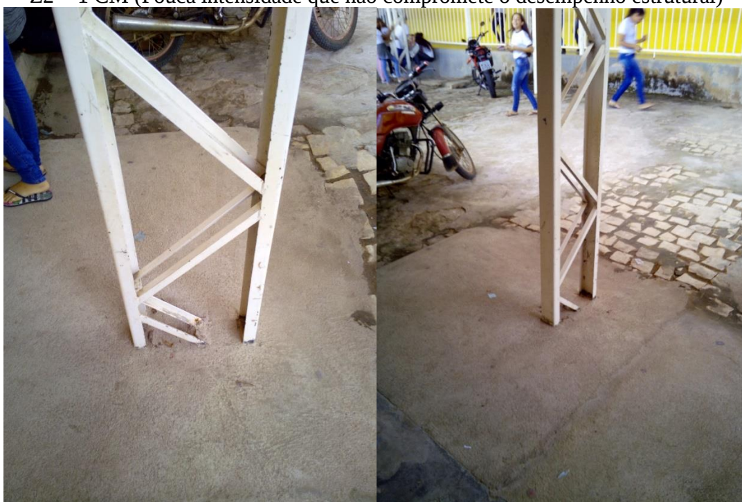
PILAR 02 Z2 = 1 CM (Pouca intensidade que não compromete o desempenho estrutural)
