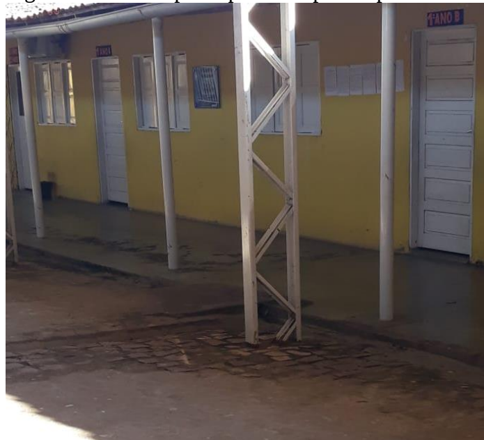
Figura 20 – Pilar tipo responsável por suspender a estrutura
