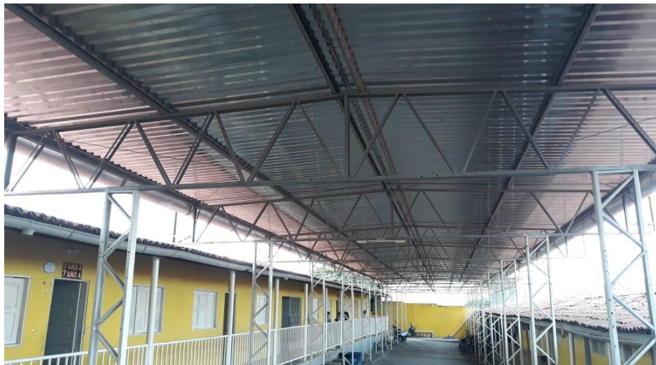
Figura 18 - Estrutura Metálica do pátio da escola
