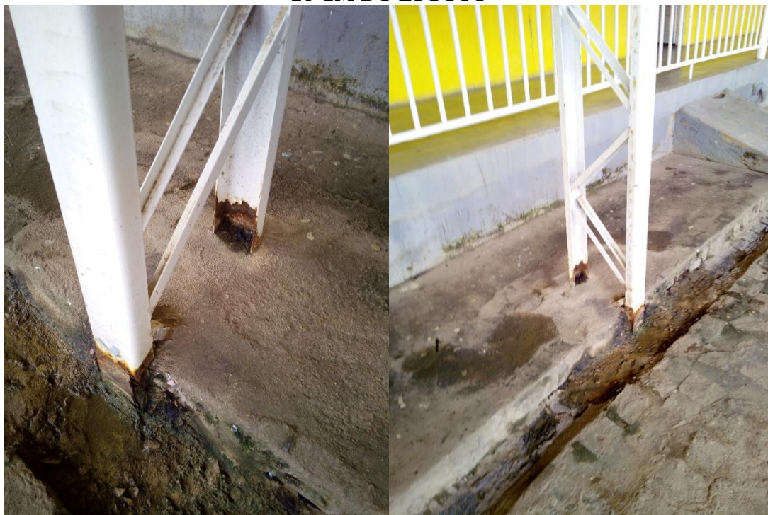
PILAR 16 Z16 = 10 CM DA CALÇADA 26 CM DO ESGOTO
