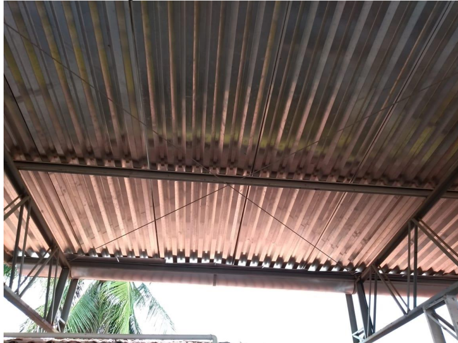
Figura 19 - Contraventamento Horizontal
