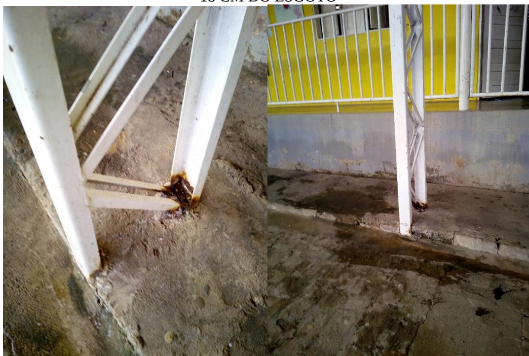
PILAR 20 Z20 = 8 CM DA CALÇADA 18 CM DO ESGOTO
