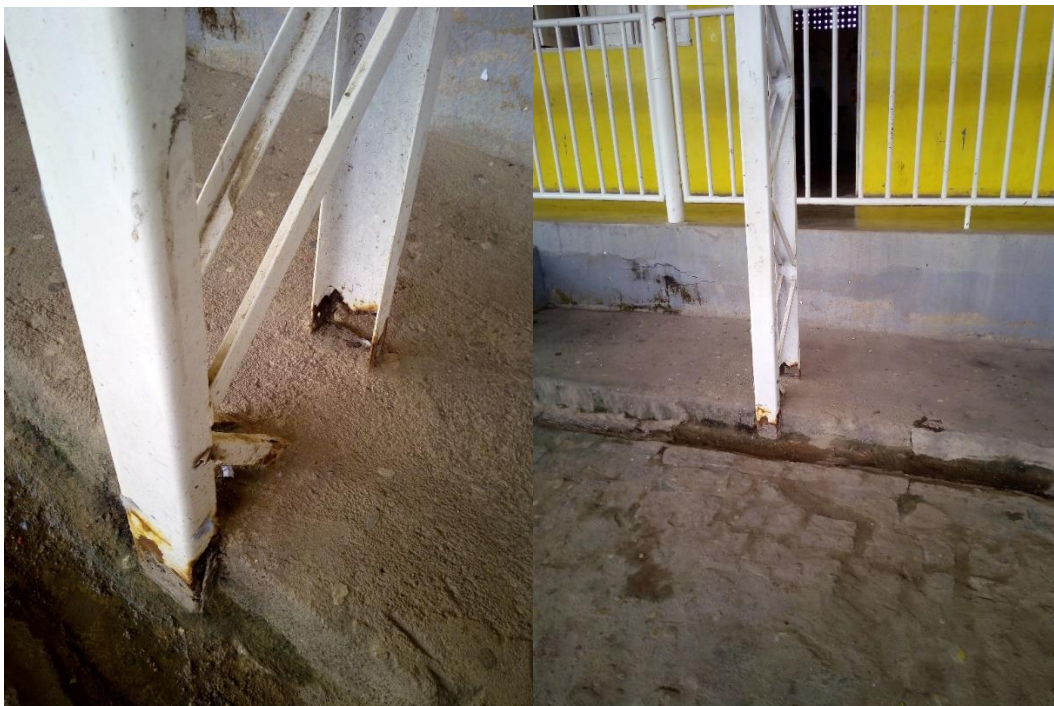
PILAR 17 Z17 = 10 CM DA CALÇADA 22 CM DO ESGOTO
