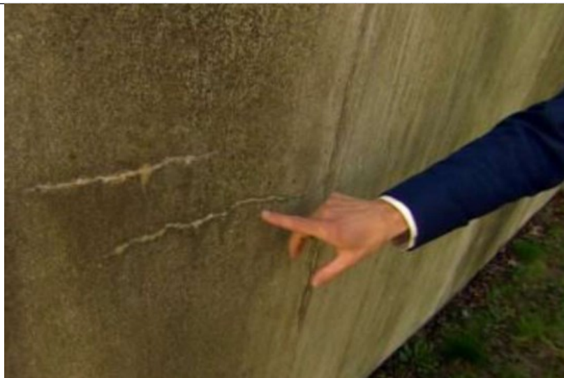
Figura 3. Parede da estação Salva Vidas. (Jonkers,2015)
