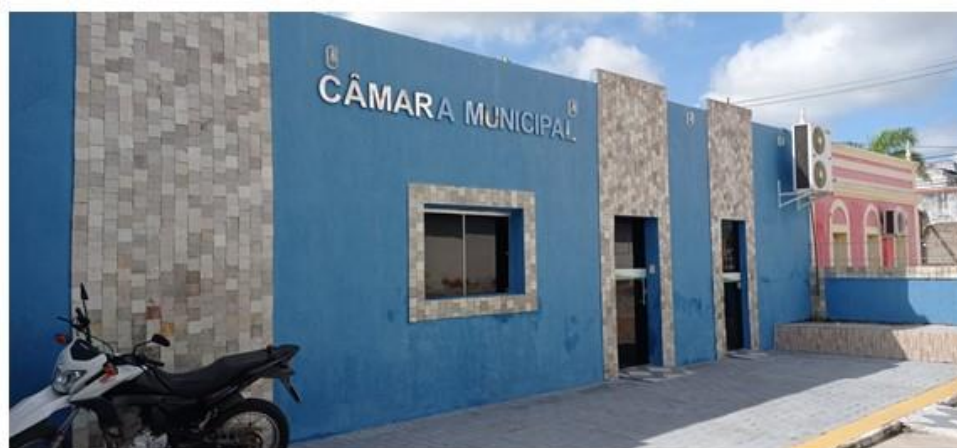
FACHADA DA CÂMARA MUNICIPAL DE AFONSO BEZERRA
