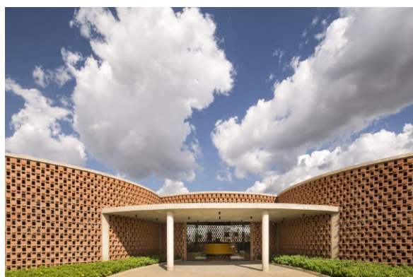
Figura 23: Paginação de tijolos e pano vazado nas fachadas da Academia Escola Unileão
