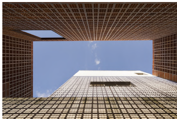
Figura 38: Segunda pele como proteção da luz solar
