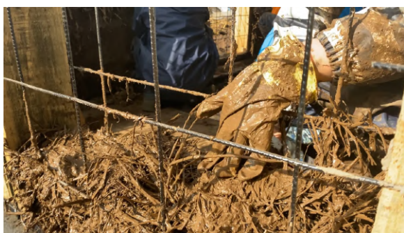
Figura 61: Sistema construtivo quinchá
