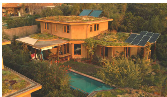
Figura 62: Uso de placas fotovoltaicas
