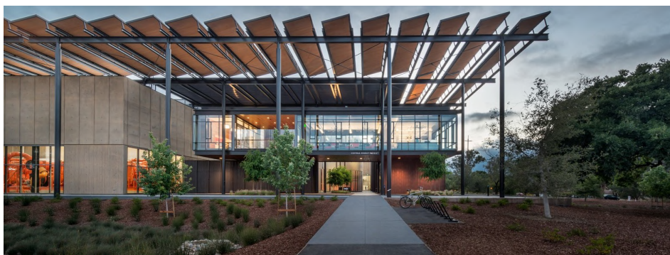
Figura 17: Painéis solares como elemento do pergolado articulado na Instalação de Ener Universidade de Stanford, Califórnia/EUA
