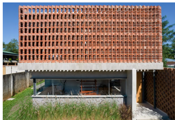
Figura 14: Arranjo de blocos cerâmicos sem aplicação de materiais como acabamento final
