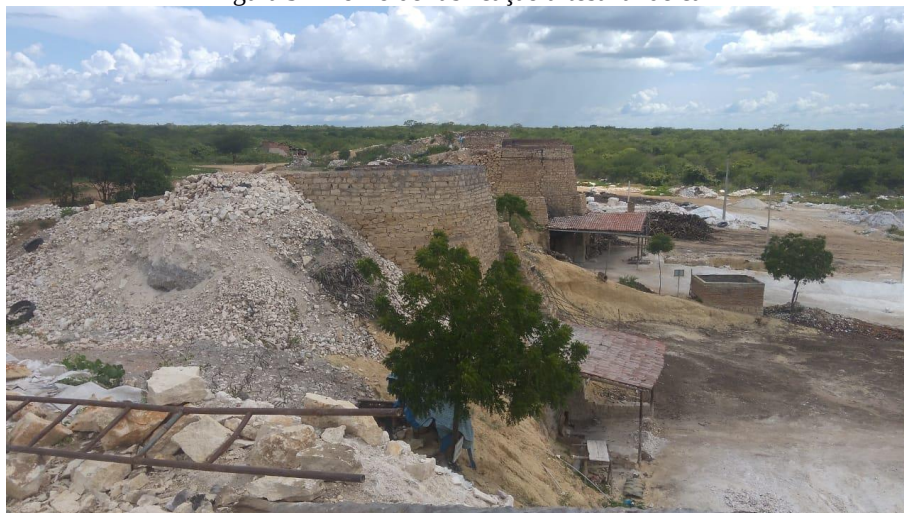
Figura 9 – Forno de fabricação artesanal de cal
