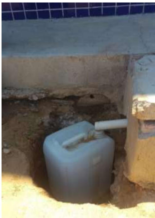
Figura 11 - Medição do bloco A de salas de aula
