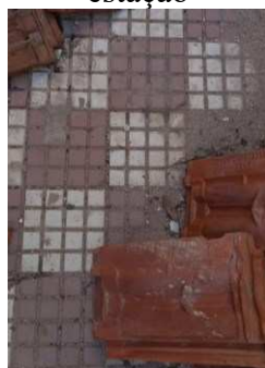
Figura 52 – Piso da estação
