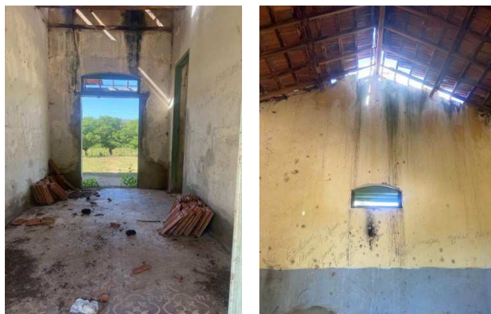
Figura 43 – Imagens internas da estação
