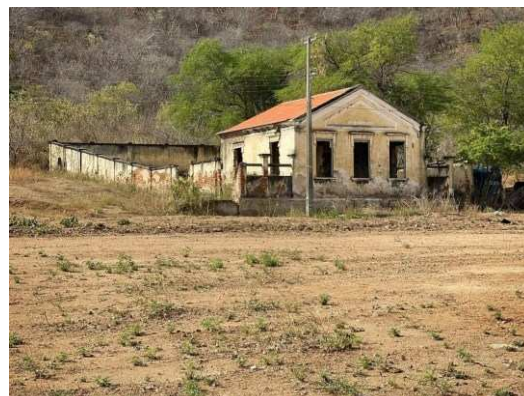
Figura 34 – Casa do agente depois da reforma
