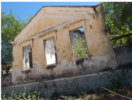
Figura 33 – Casa do agente antes da reforma
