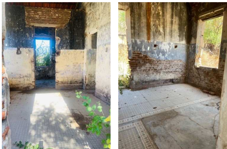
Figura 45 – Imagens internas da estação
