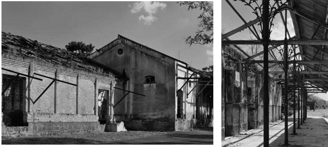
Figura 54 – Edificações antes da requalificação
