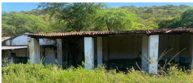
Figura 47 – Imagens internas do depósito
