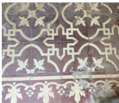
Figura 51 – Piso da estação
