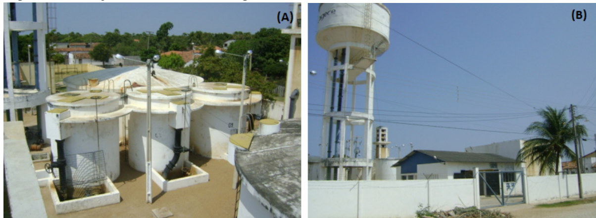
Figura 6 – Estação de tratamento de água - ETA(A) e vista ETA(B).
