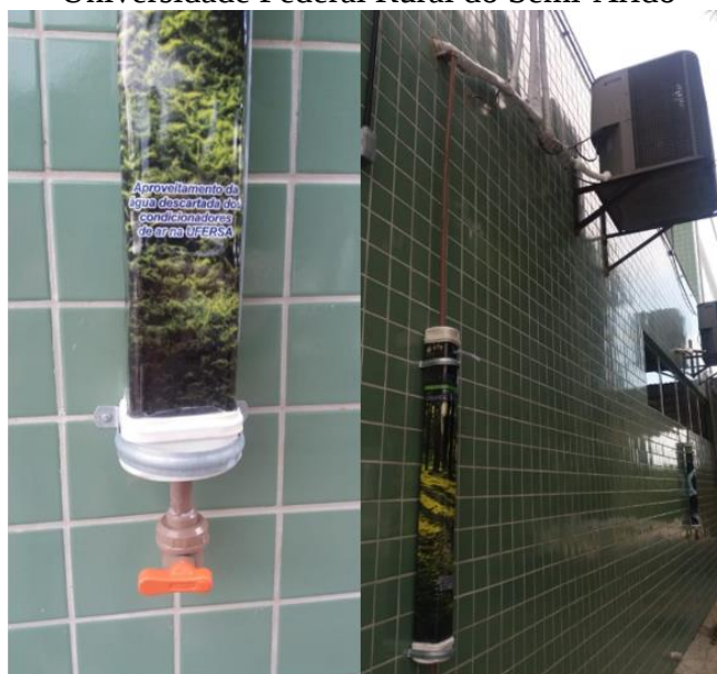
Figura 43 - Sistema de aproveitamento da água descartada de condicionadores de ar na Universidade Federal Rural do Semi-Árido
