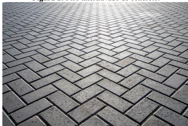
Figura 2: Piso intertravado de concreto.
