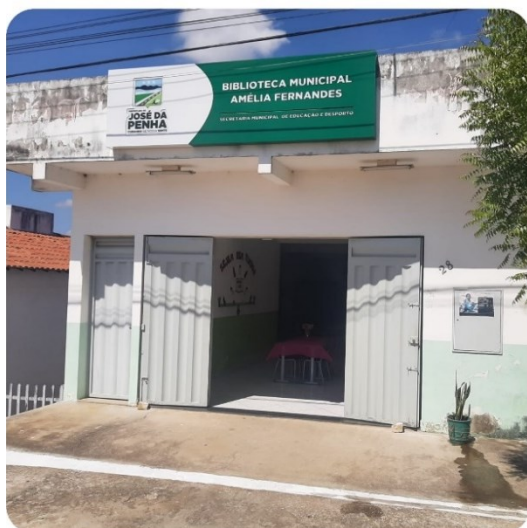
Figura 23: Acesso a Biblioteca Municipal.
