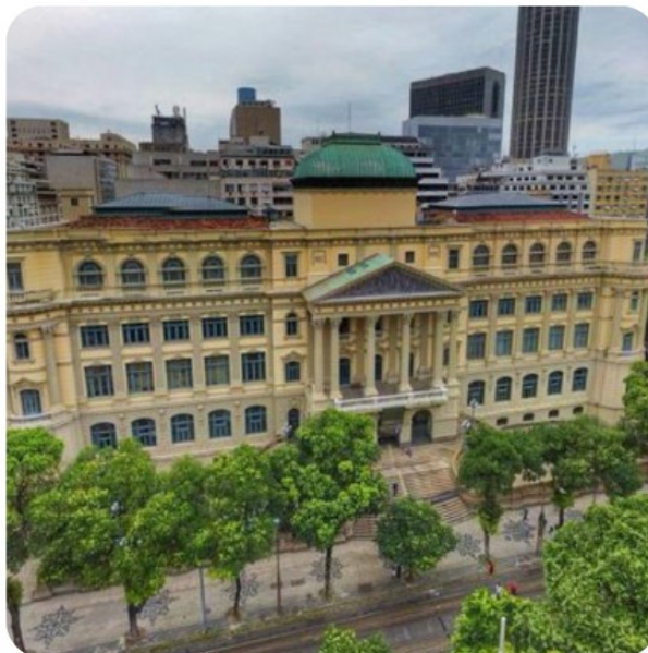
Figura 10: Fachada da Biblioteca Nacional, Rio de Janeiro, Brasil.
