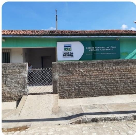
Figura 58: Creche Municipal Antônio Vieira do Nascimento.
