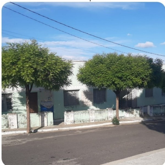
Figura 21: Fachada da antiga sede da Biblioteca Municipal.
