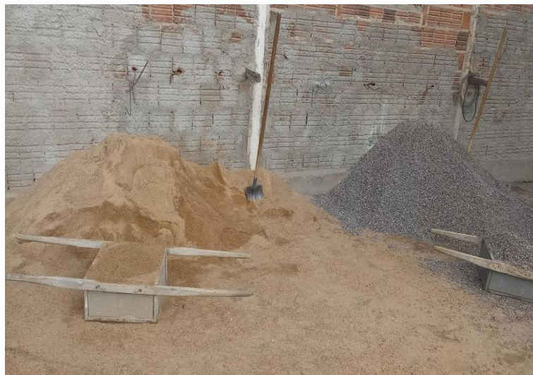
Figura 6. Areia e brita usados por concreteira de Caraúbas-RN
