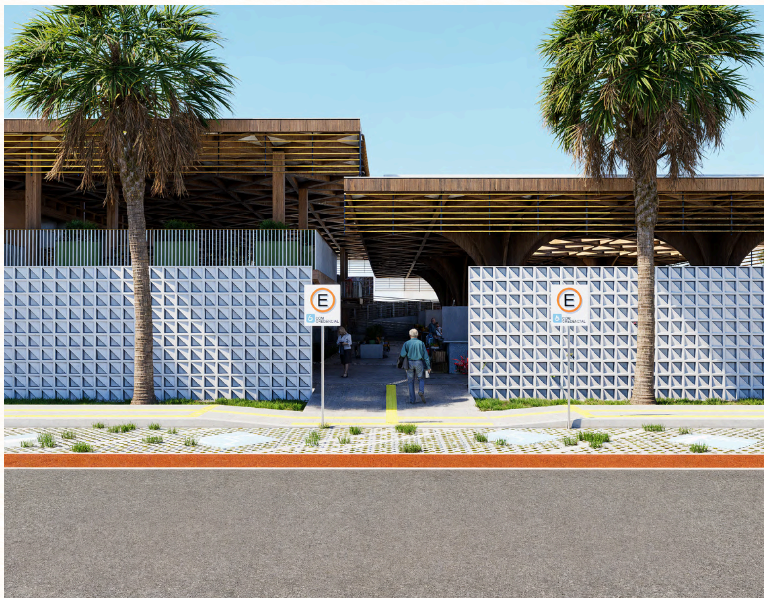
FACHADA RUA CAJAZEIRAS
