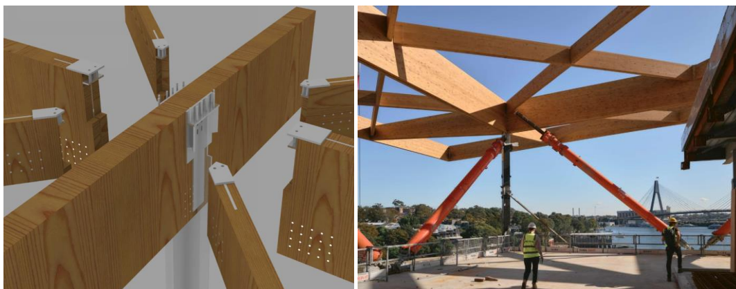
Figura 66 e 67: Conexões da cobertura e Construção da Cobertura, em 2021
