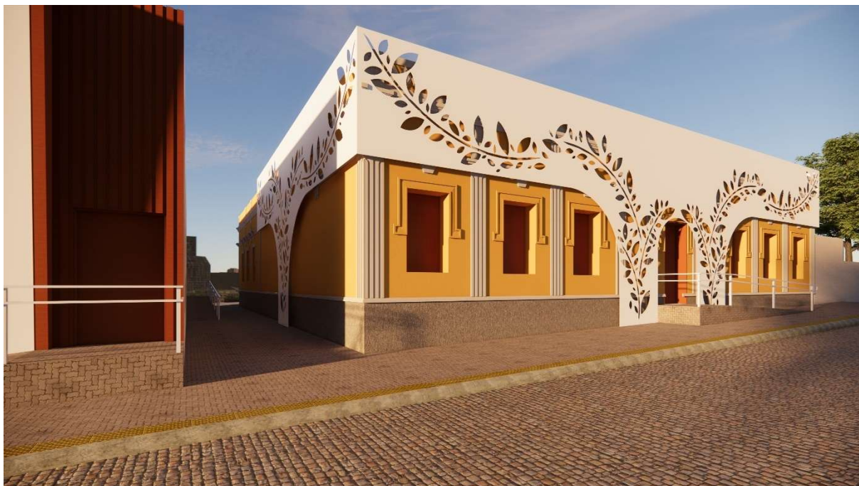
Figura 77 - intervenção na fachada falsa.
