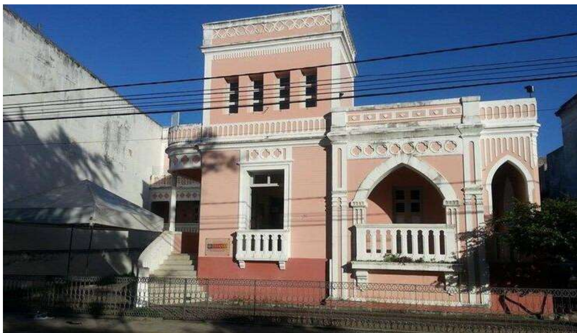
Figura 8 - Superintendência estadual do IPHAN.
