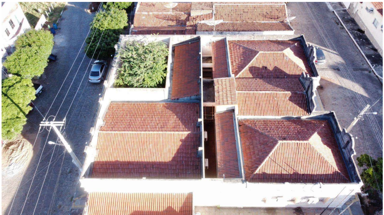
Figura 51 - Imagem aérea do telhado da edificação.
