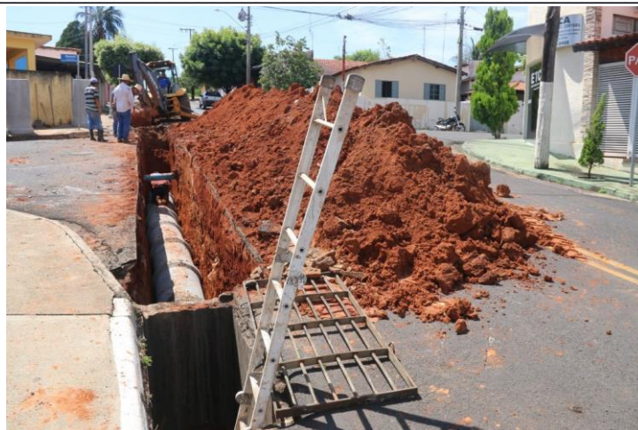
Figura 3: Construção de sistema de galerias pluviais . Fonte: Diario de Olinda.
