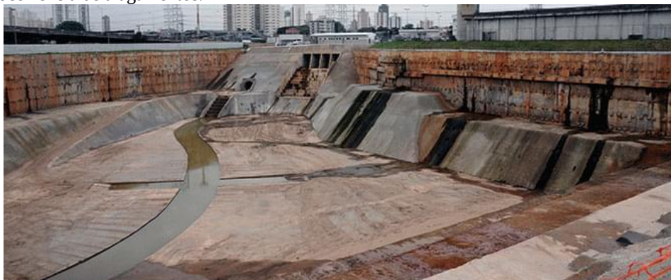
Figura 2: Picinão em construção. Fonte: AEC Web.
