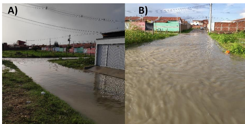
Figura 6: Ruas alagadas. Fonte: Autoria própria.
