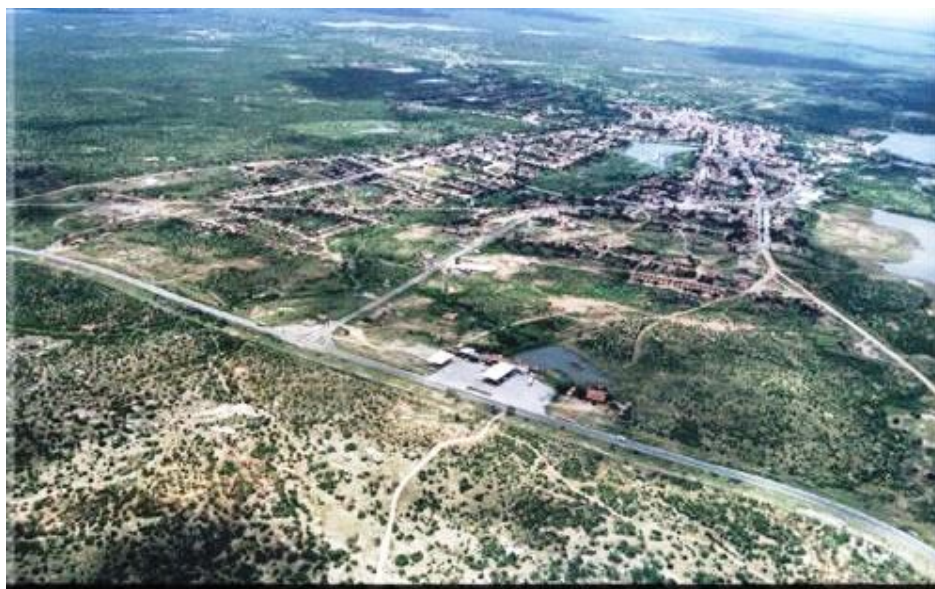
Figura 16 – Vista aérea da cidade de Angicos – RN.
