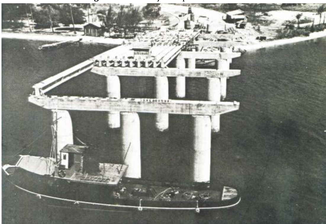
Figura 1- Construção da ponte do Galeão
