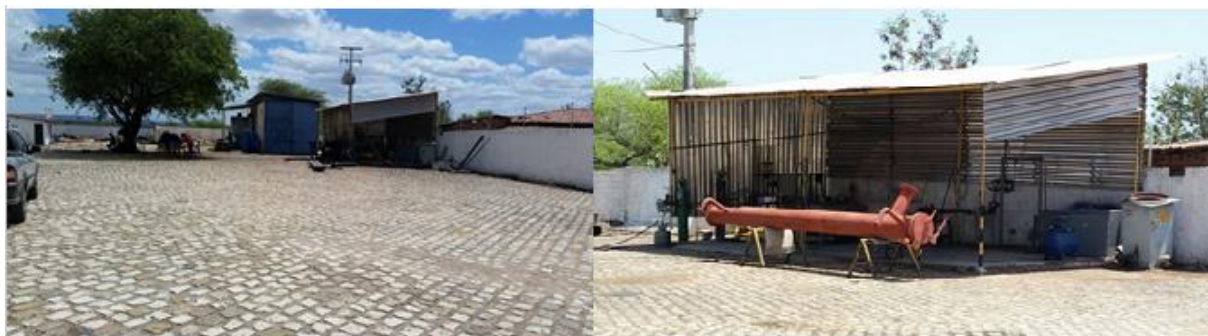
Figura 9: Canteiro de Obras da FB MONTAGENS
