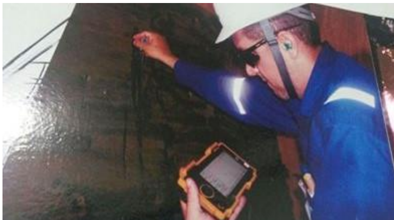
Figura 10: Realização de Ensaio por Ultrassom pelo inspetor da FB MONTAGENS
