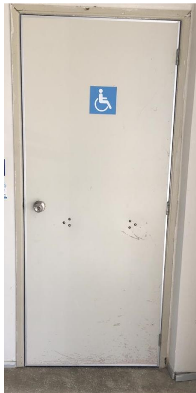
Figura 21- Porta do banheiro destinado a pessoas com necessidades especiais
