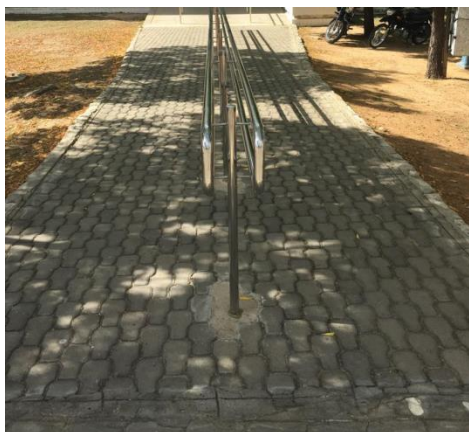
Figura 23- Rampa lateral 1 do bloco de salas de aulas 1
