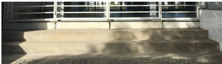
Figura 25- Escada lateral do bloco
