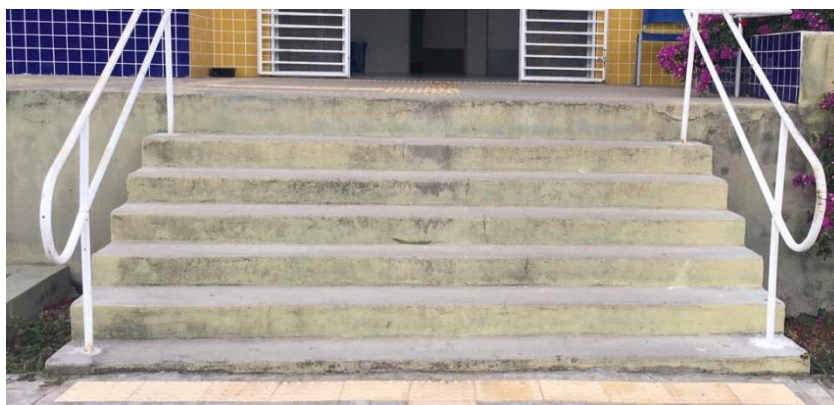
Figura 46 Escada do acesso da entrada principal
