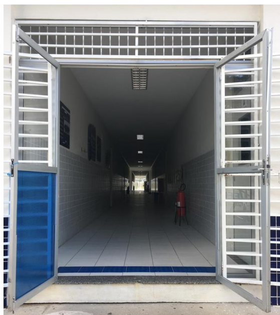
Figura 27- Porta acesso ao Bloco de laboratórios
