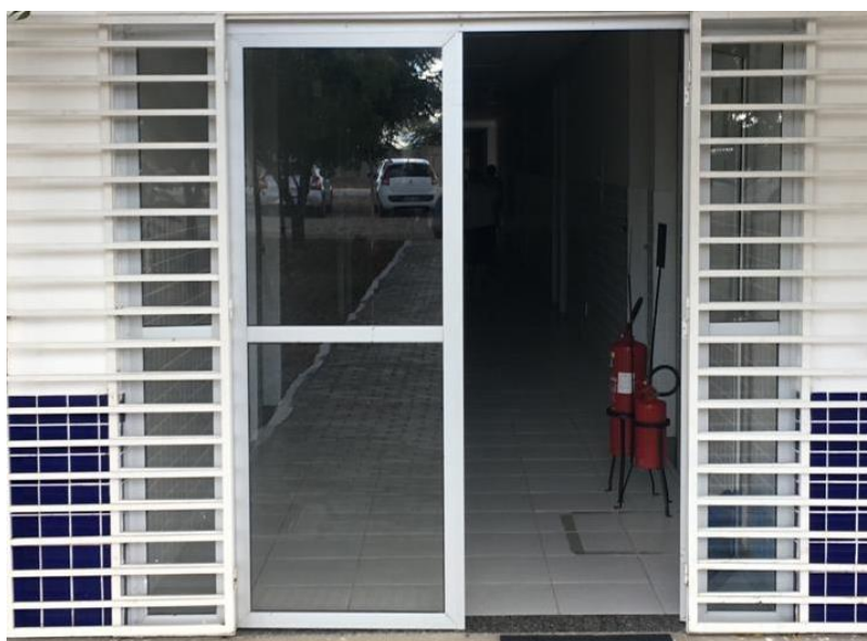
Figura 48- Porta de acesso no final do corredor
