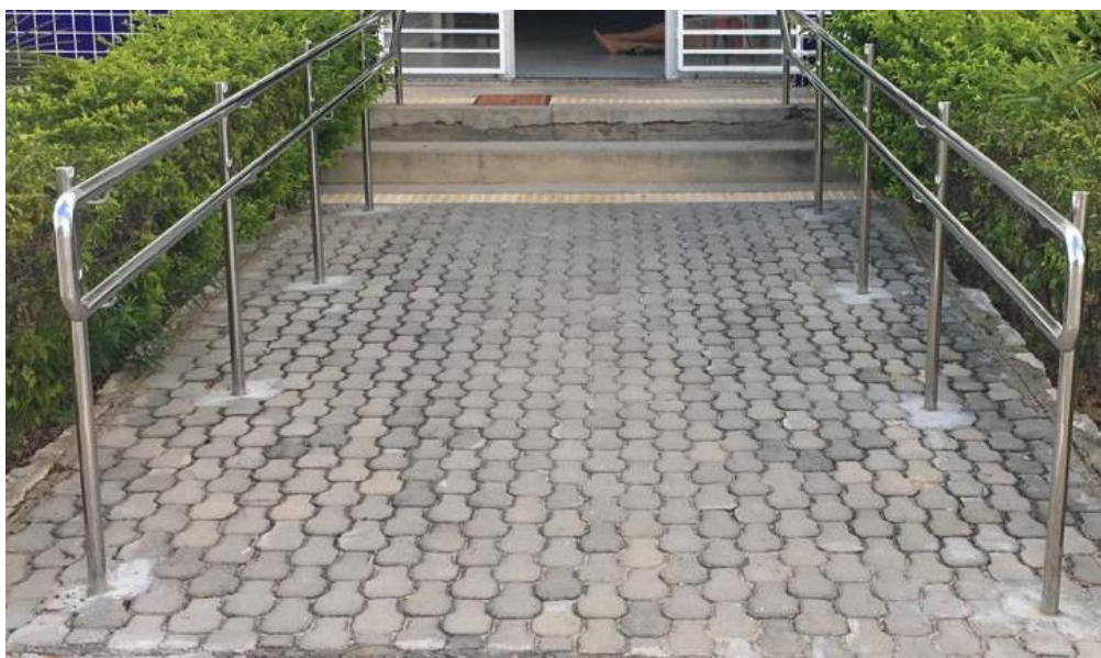
Figura 37- Rampa de entrada
