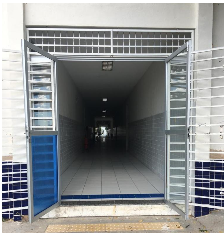
Figura 28- Porta de acesso ao Bloco de salas de aulas 2
