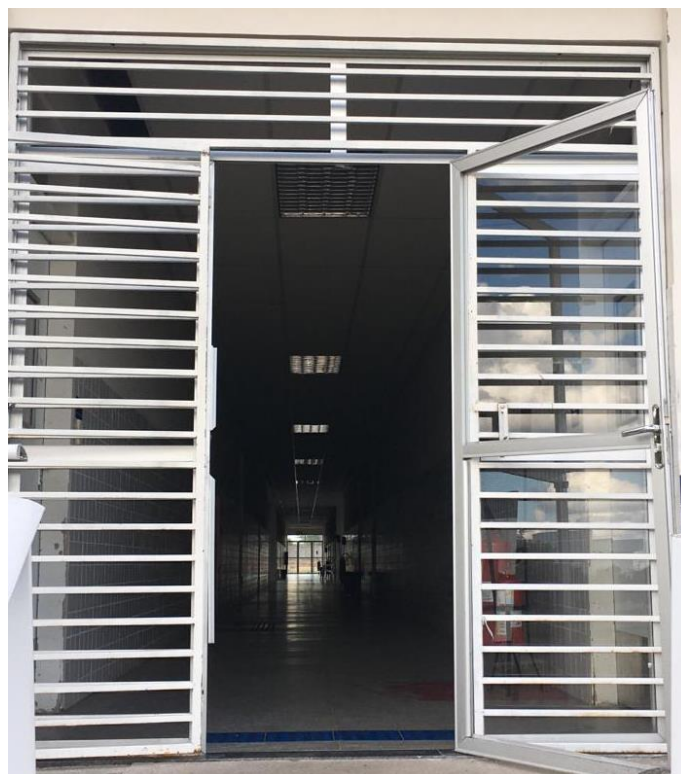
Figura 33- Porta acesso ao Bloco 1
