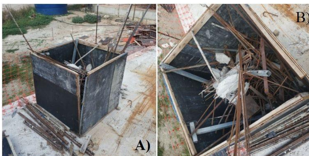
Figura 6 Disposição de resíduos de madeira na obra
