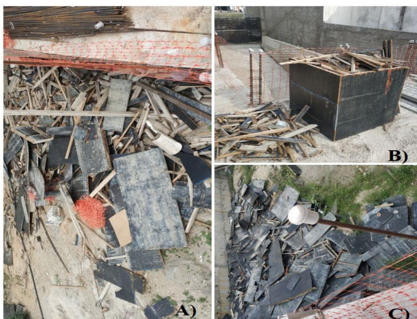
Figura 5 Disposição de resíduos de madeira na obra
