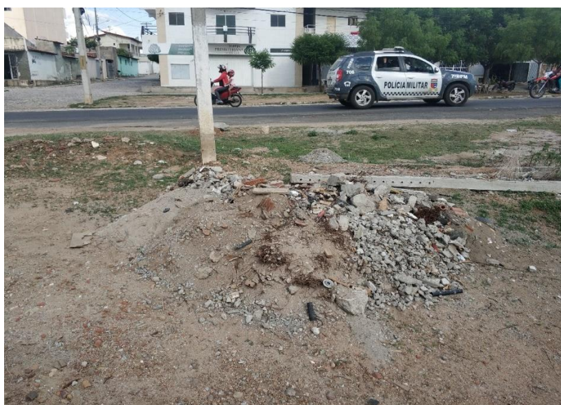
Figura 4 Disposição de resíduos da obra
