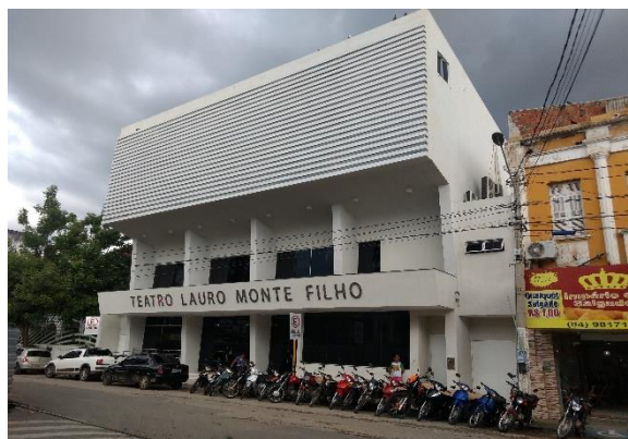
Figura 7. Fachada já restaurada do Teatro Lauro Monte Filho. Fonte: Autoria Própria
