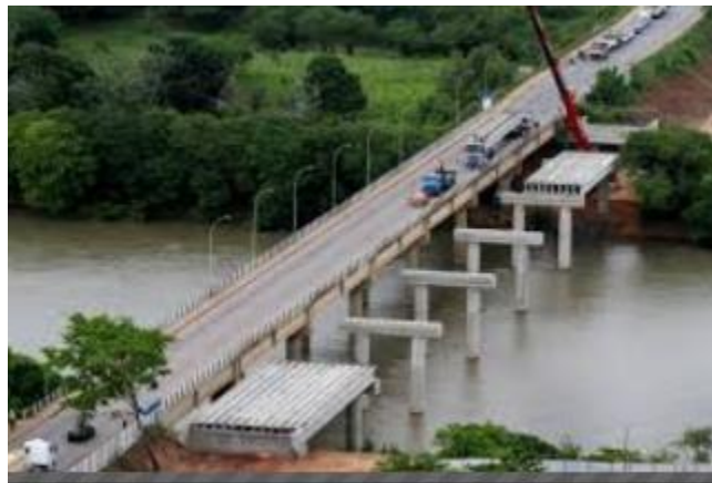
Figura 9: Construção de uma ponte pré-fabricada
