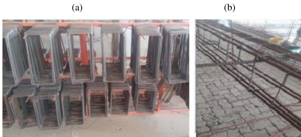
Figura 11: Peças prontas (a) estribos armazenados; (b) estribos colocados no poste antes da concretagem
