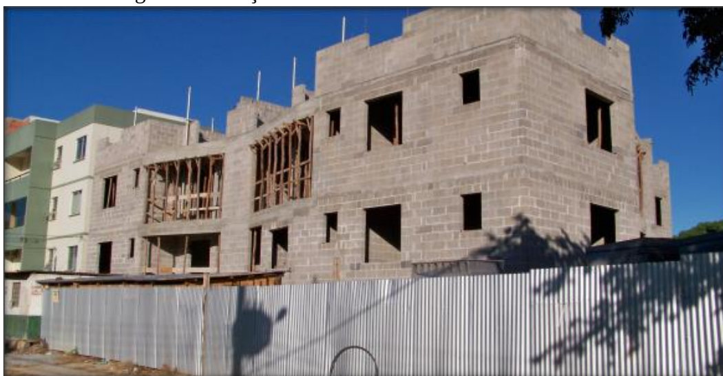
Figura 5: Vedação vertical em bloco de concreto.
