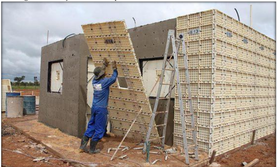
Figura 4: Vedação vertical em painéis de concreto moldados in loco .
