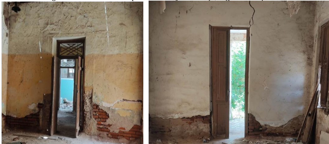
Figura 42 - Revestimento paredes em tijolo maciço, argamassa e pintura.
