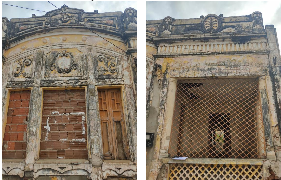
Figura 36 - Detalhes fachada leste
