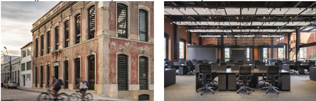
Figura 84 - Janelas contemporâneas na fachada e utilização de fechamentos de vidro.
