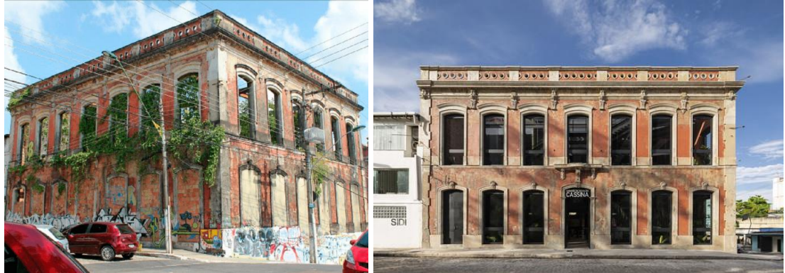
Figura 11 - Antes e depois do processo de restauração do antigo Hotel Cassina em Manaus-AM.
