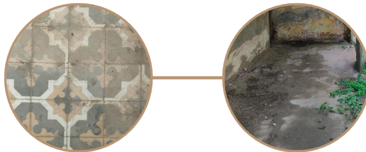
Figura 44 - Piso de ladrilho hidráulico e cimentício.
