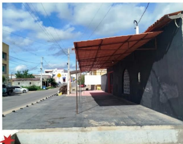
Figura 67 - Apropriação comercial na rua São João
