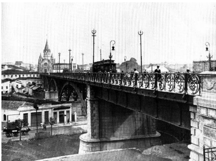
Figura 5 - Iluminação pública do Viaduto de Santa Efigênia, São
