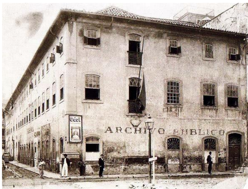
Figura 2 - Iluminação pública da rua da Assembleia, Rio de Janeiro, 1904.
