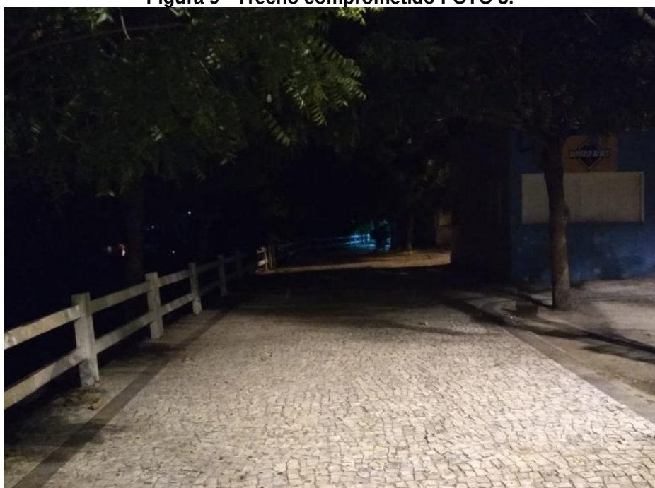
Figura 9 - Trecho comprometido FOTO 3.
