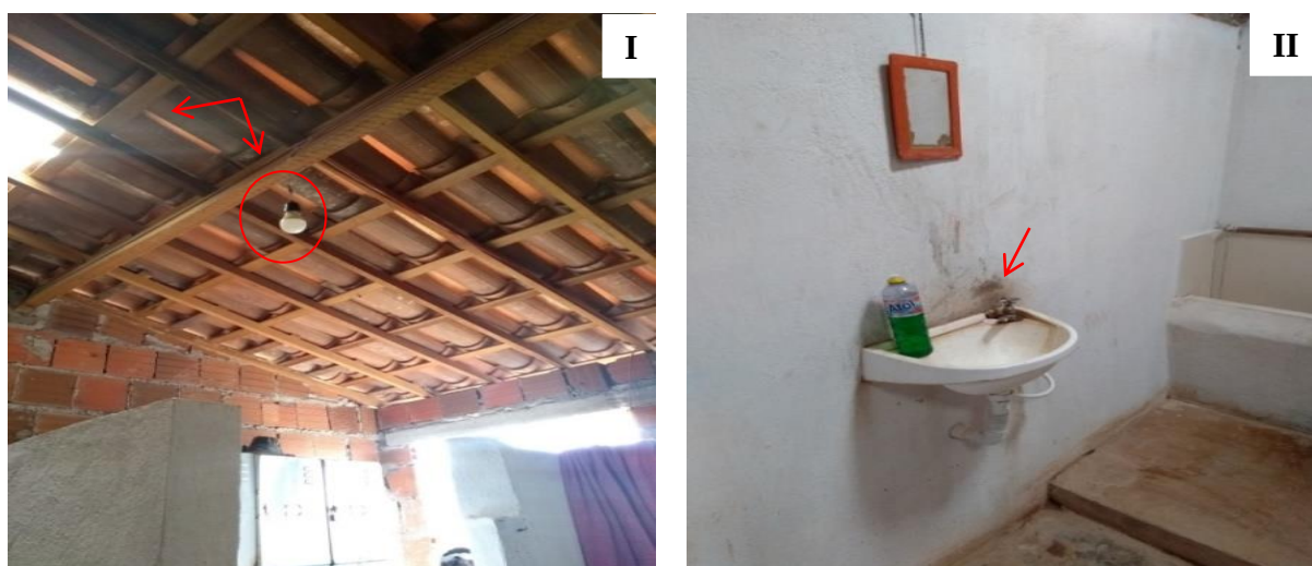
Figura 3 - Instalações sanitárias da Obra B
