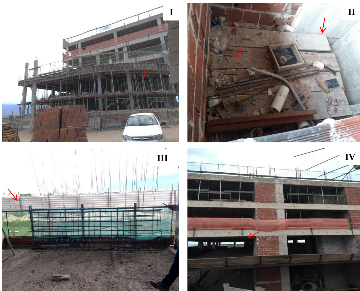
Figura 11 - Proteções contra quedas de altura da Obra B
