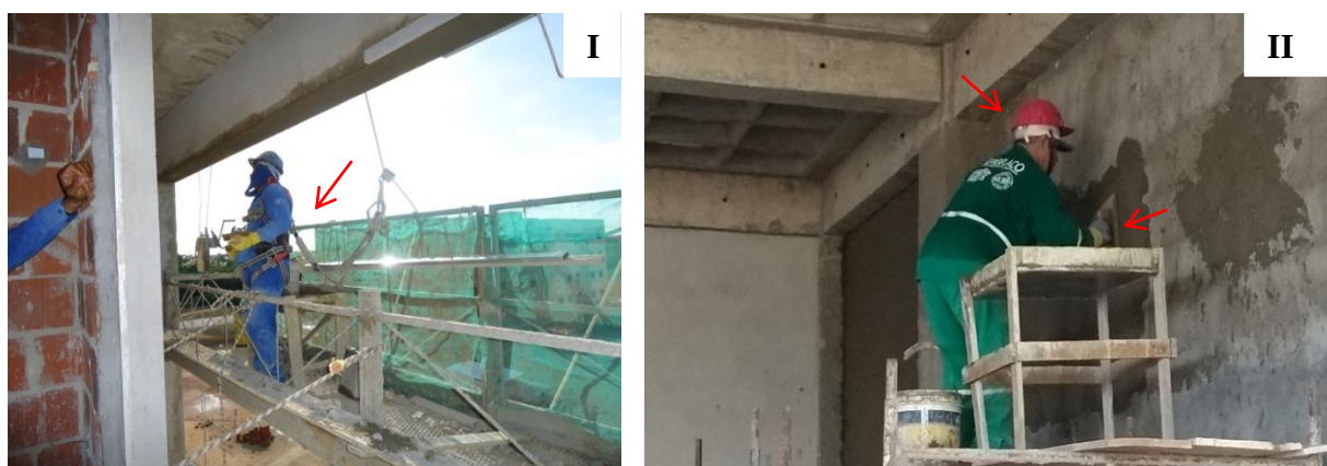
Figura 20 - Equipamentos de proteção individual nos canteiros
