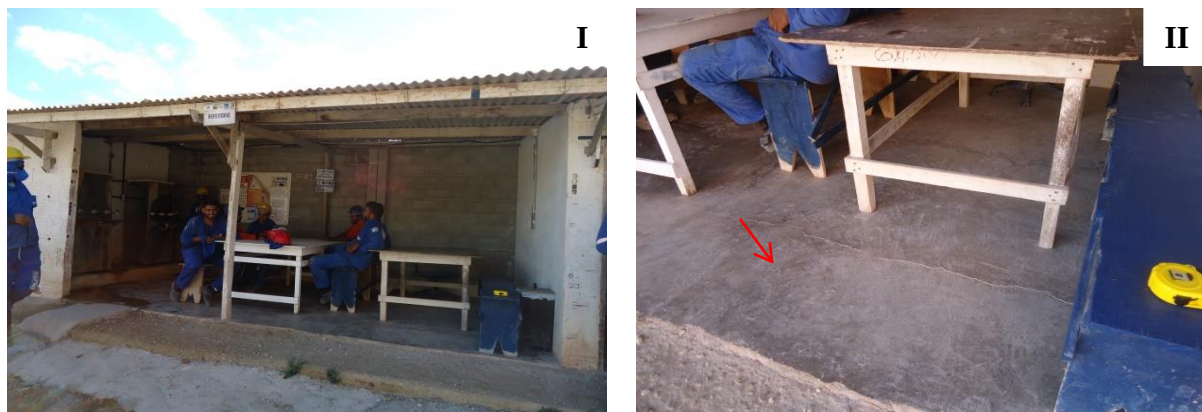
Figura 9 - Local para refeições da Obra A
