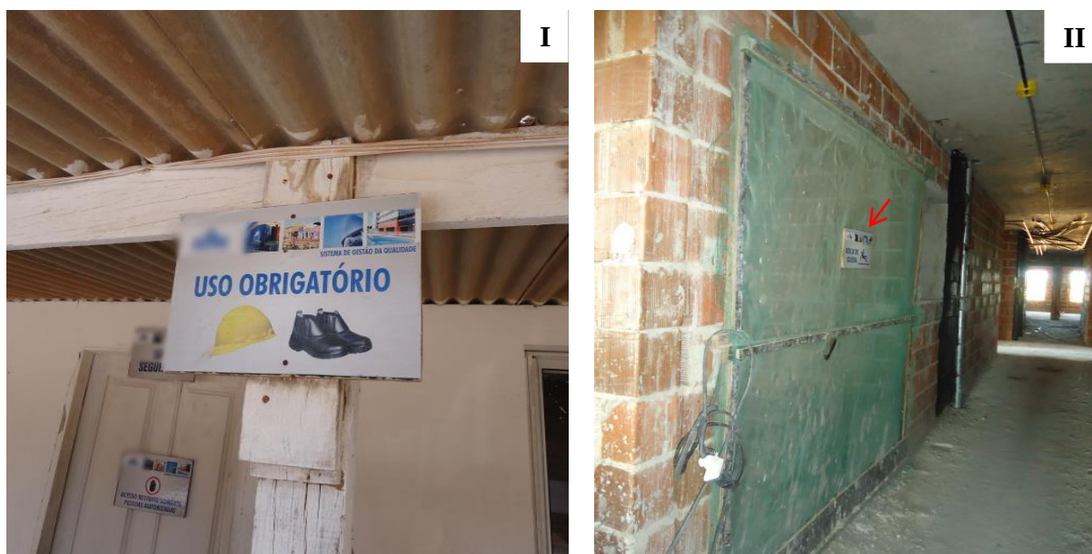
Figura 21 - Sinalizações de segurança nos canteiros
