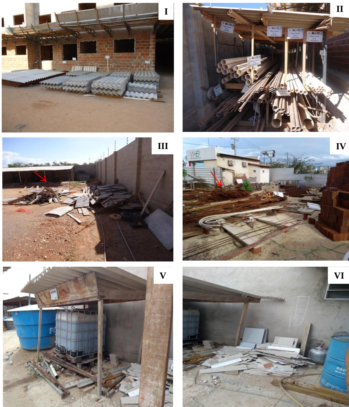
Figura 23 - Ordem e limpeza dos canteiros de obra
