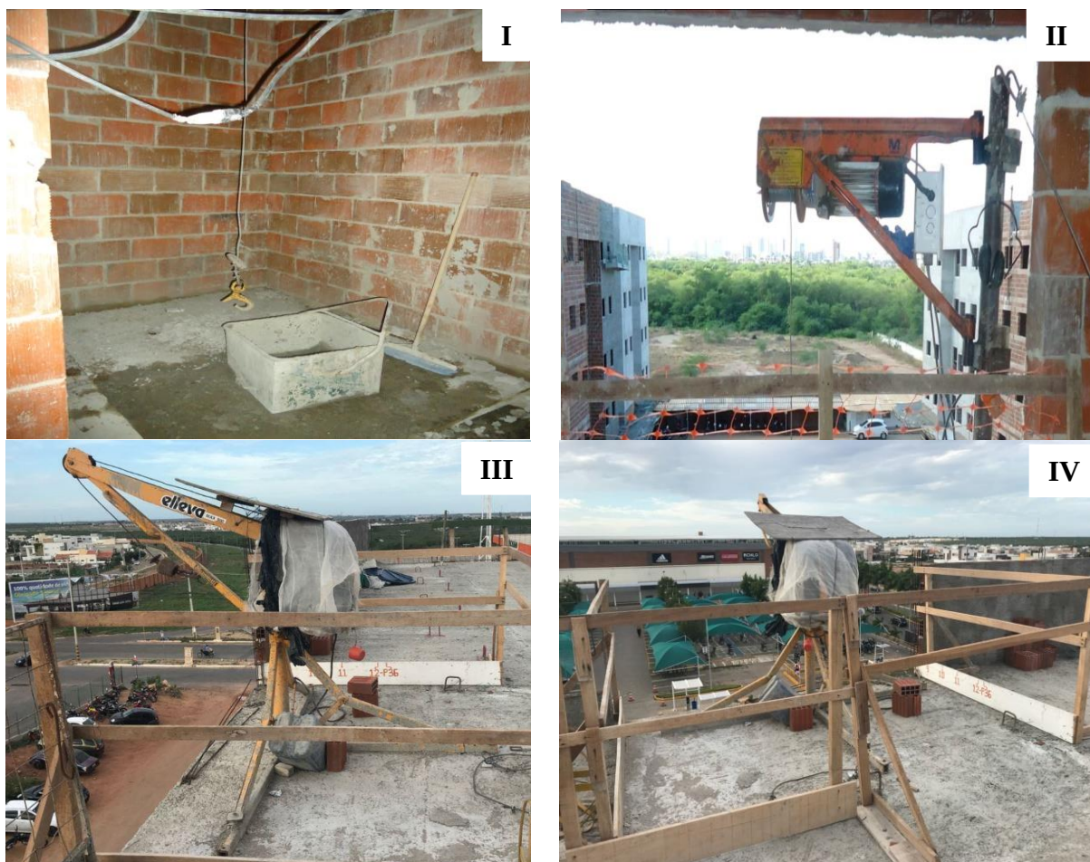
I: tambor do guincho de coluna da Obra A; II: visão lateral do guincho de coluna da Obra A; III: visão lateral da mini grua da Obra B; IV: visão posterior da mini grua da Obra B. Fonte: Dados da pesquisa (2018).
