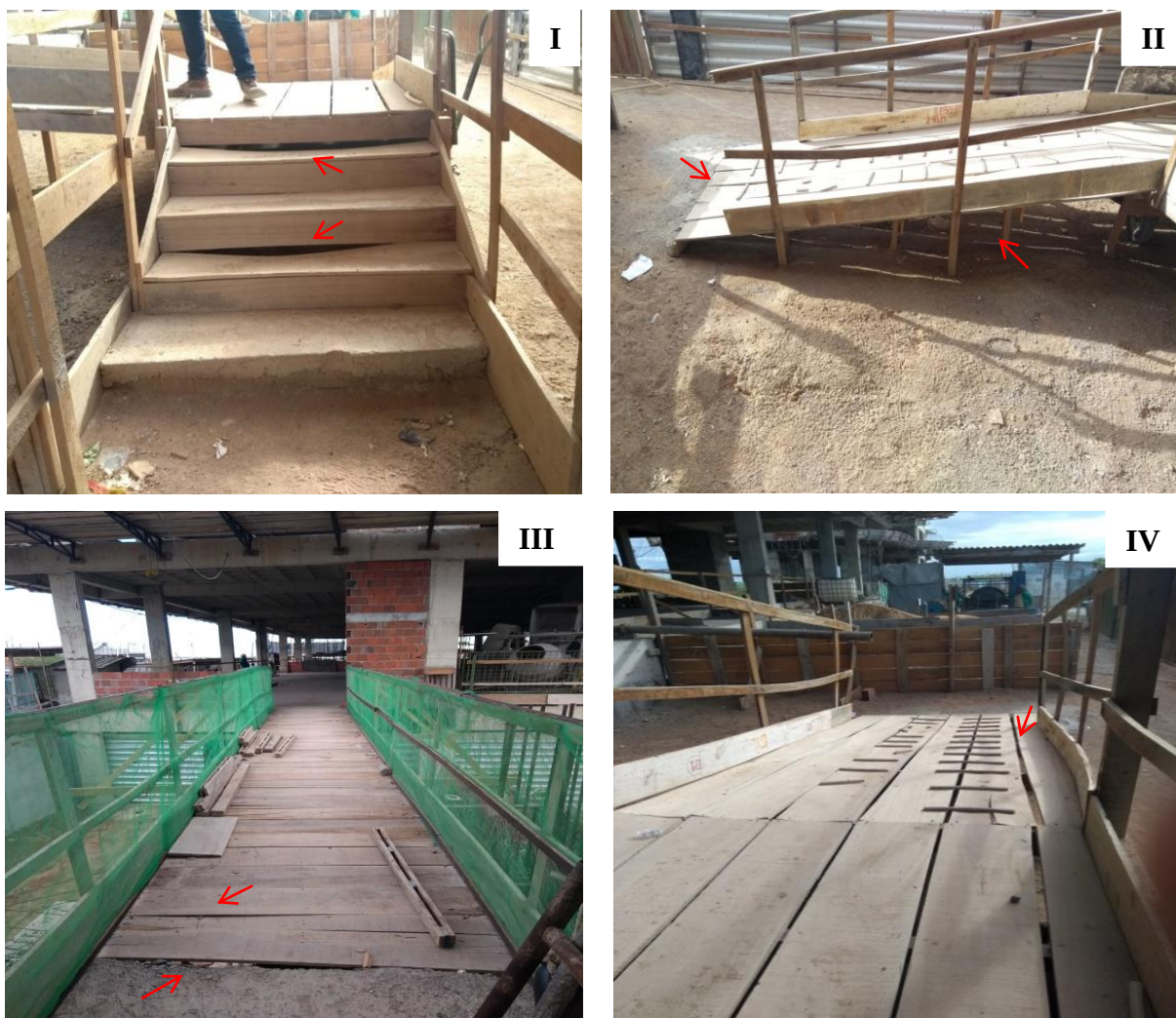
Figura 14 - Escadas, rampas e passarelas da Obra B
