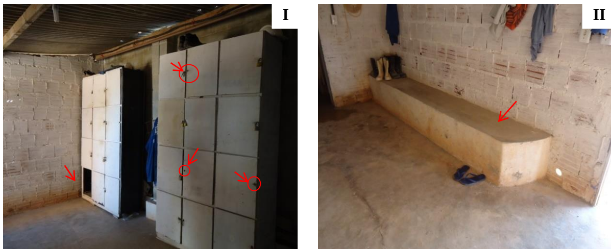
Figura 7 - Vestiário da Obra A
