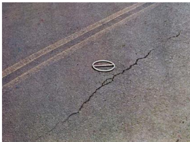
Figura 6 - Trinca longitudinal
