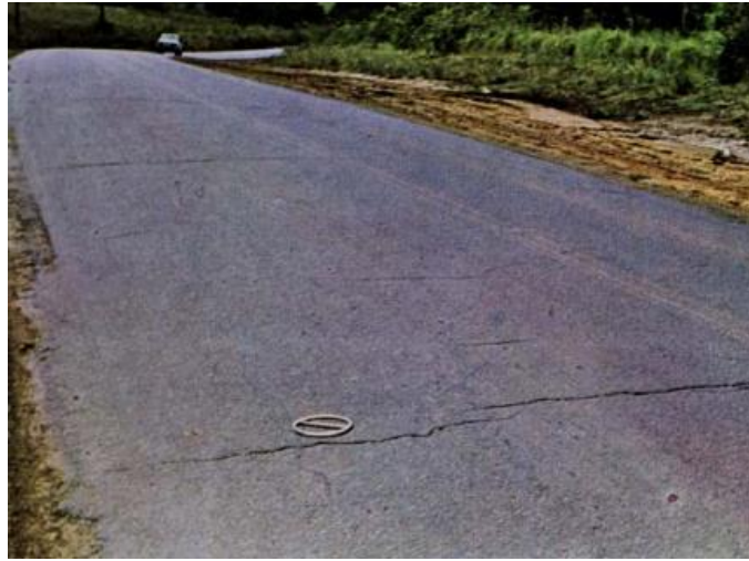
Figura 5 - Trincas transversais
